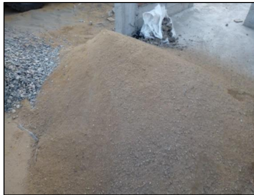
Figura 3 Almacenamiento de agregado fino
