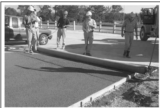
Figura 13 Compactación de pavimentos
