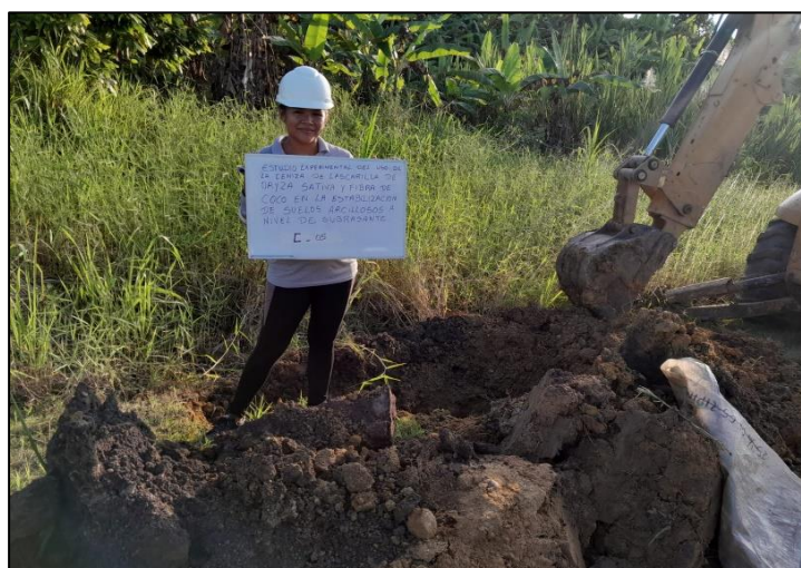
Ilustración 11: Zona de excavación de la C-05
