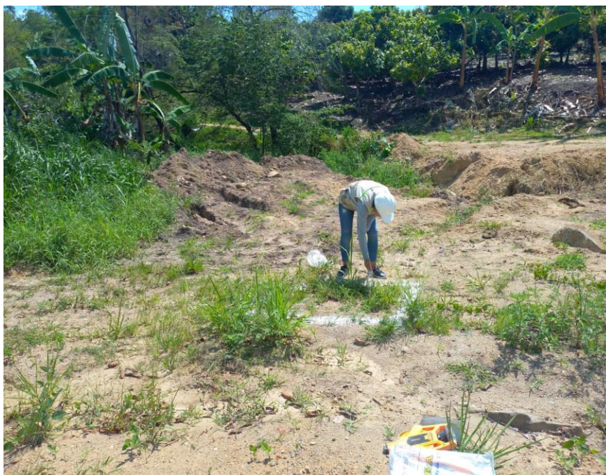
Se realizó el trazo para las calicatas
