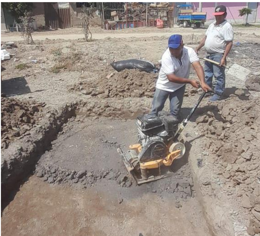
Compactación de material por capas en la zona de estudio
