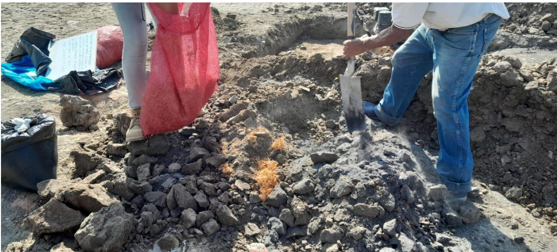
Combinación de la CCA y FDC con el suelo arcilloso natural
