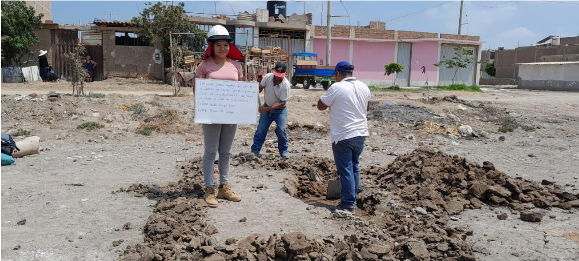
Excavación para realizar el Ensayo de Densidad de Campo
