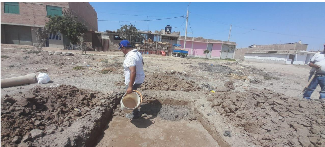
Colocación del material al área excavada
