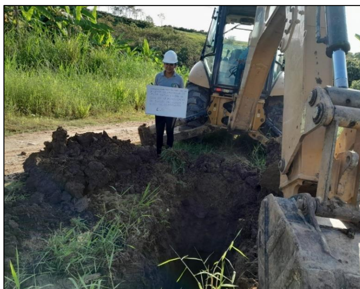
Ilustración 9: Zona de extracción de la C-03
