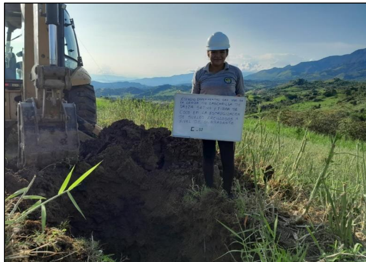
Ilustración 8: Zona de extracción de la C-02
