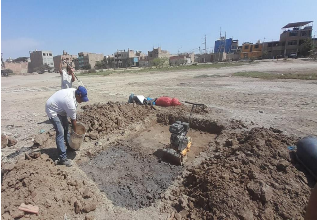
Rocío de agua al material de la CCA y FDC con el suelo natural
