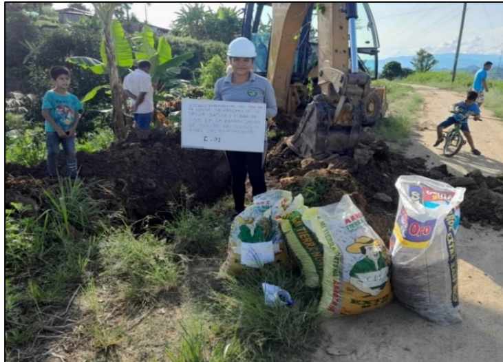
Ilustración 7: Excavación y extracción de las muestras de la C-01
