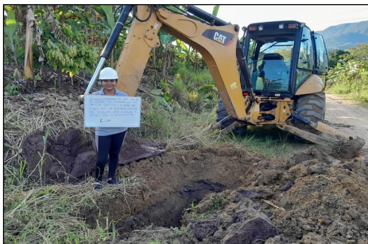
Ilustración 10: Zona de Excavación de la C-04
