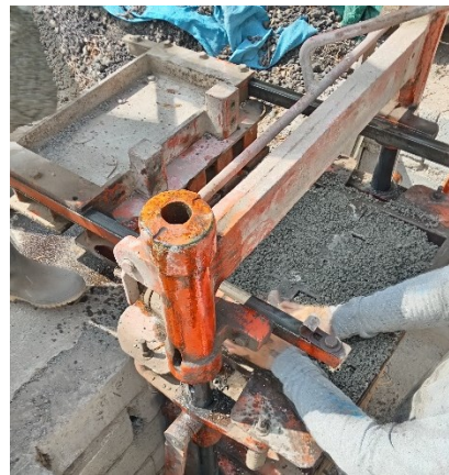
Fig. 64. Vaciado de la mezcla a la maquina Vibro compactadora
