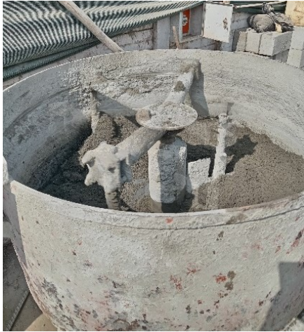
Fig. 61. Mezcla de los agregados en la Olla de mezclado
