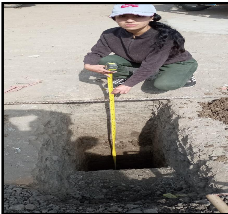
Ilustración 39: Exploración de Calicatas-C1
