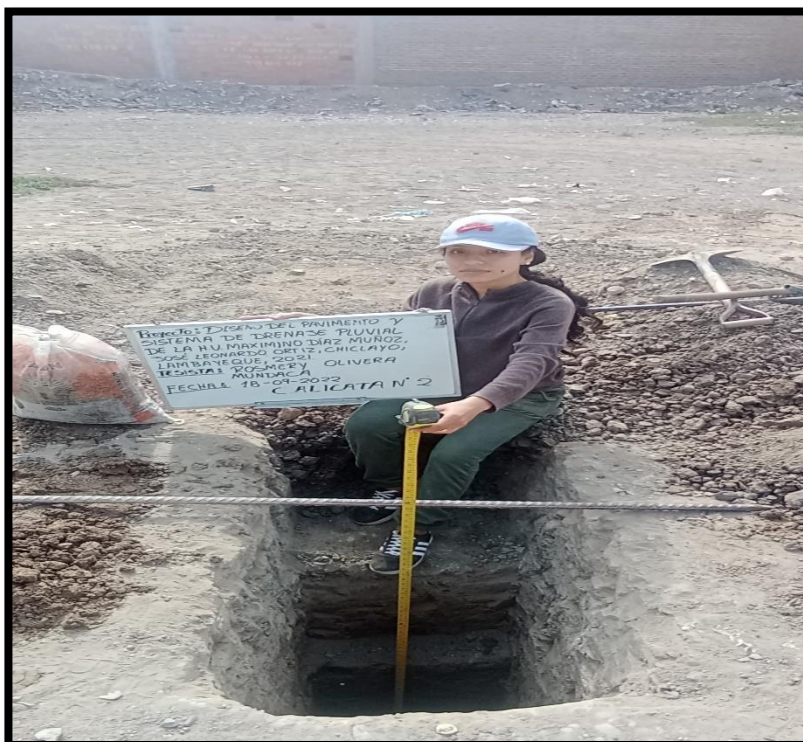
Ilustración 41: Exploración de Calicatas
