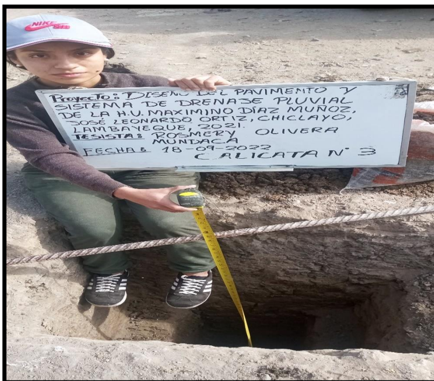
Ilustración 40: Exploración de Calicata -C3
