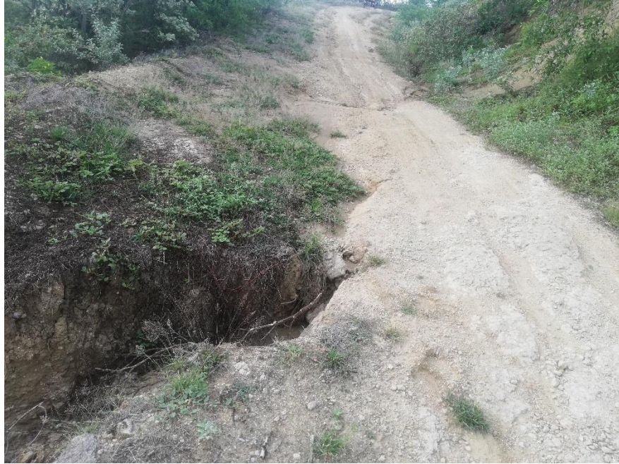
Fotografía 10: Estado actual del tramo de estudio
