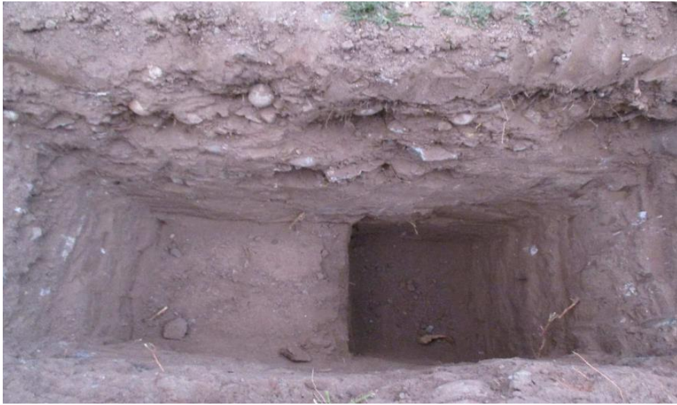
Fotografía 53: Panorama a cielo abierto de la calicata N°10 – KM. 9+000
