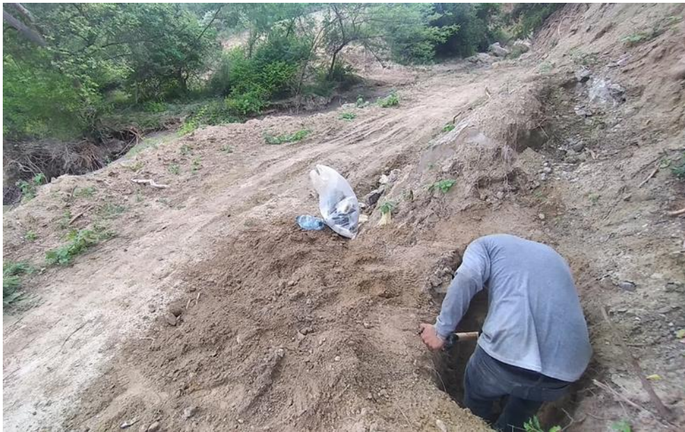
Fotografía 52: Panorama a cielo abierto de la excavación calicata N°10 – KM. 9+000
