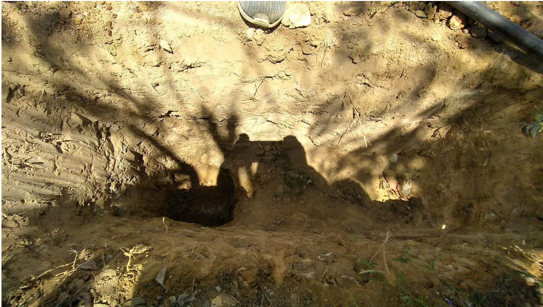
Fotografía 37: Panorama a cielo abierto de la calicata N°02 – KM. 1+000
