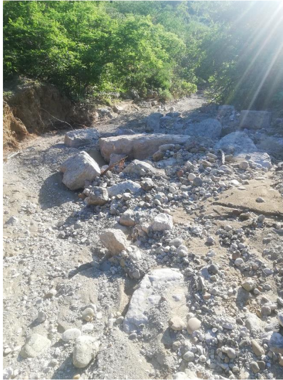
Fotografía 12: Estado actual del tramo de estudio
