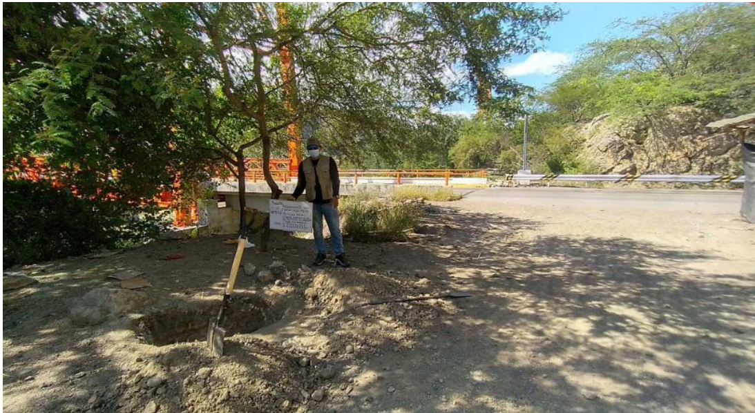
Fotografía 54: Panorama a cielo abierto de la calicata N°11 – KM. 9+700
