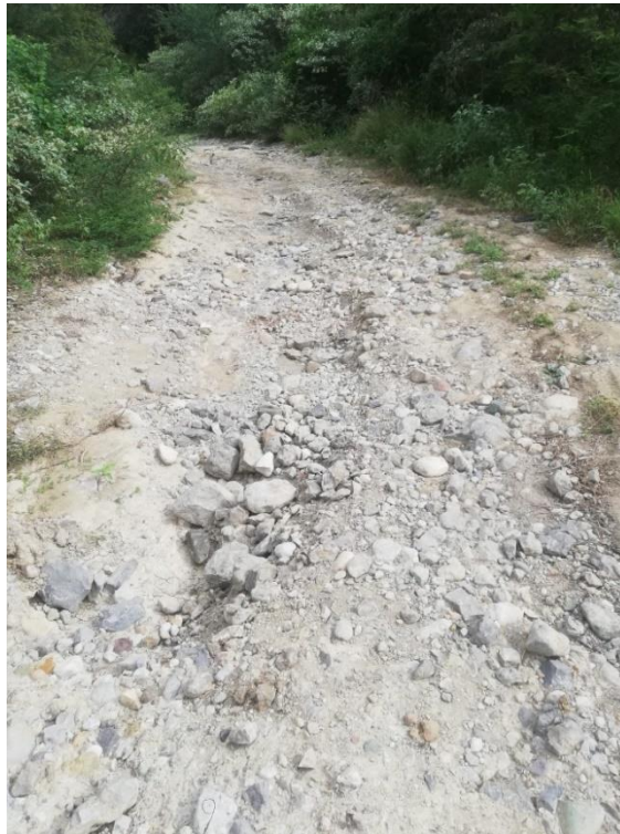
Fotografía 15: Estado actual del tramo de estudio
