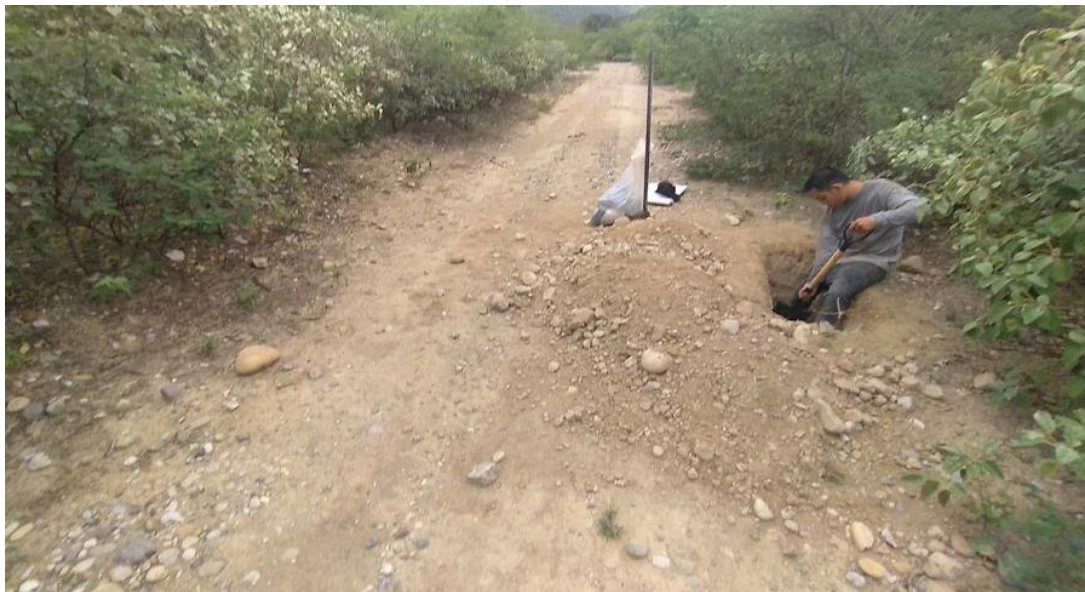
Fotografía 48: Panorama a cielo abierto de la excavación calicata N°08 – KM. 7+000
