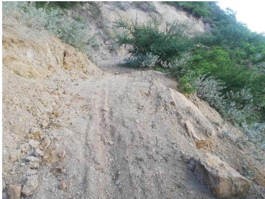
Fotografía 11: Estado actual del tramo de estudio
