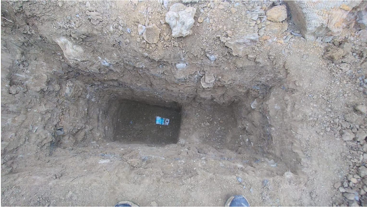
Fotografía 45: Panorama a cielo abierto de la calicata N°06 – KM. 5+000
