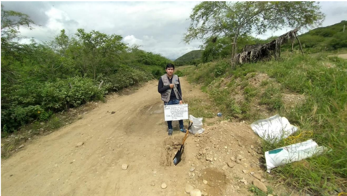
Fotografía 32: Panorama a cielo abierto de la calicata N°01 – KM. 0+000
