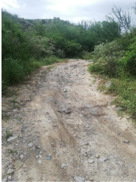
Fotografía 14: Estado actual del tramo de estudio
