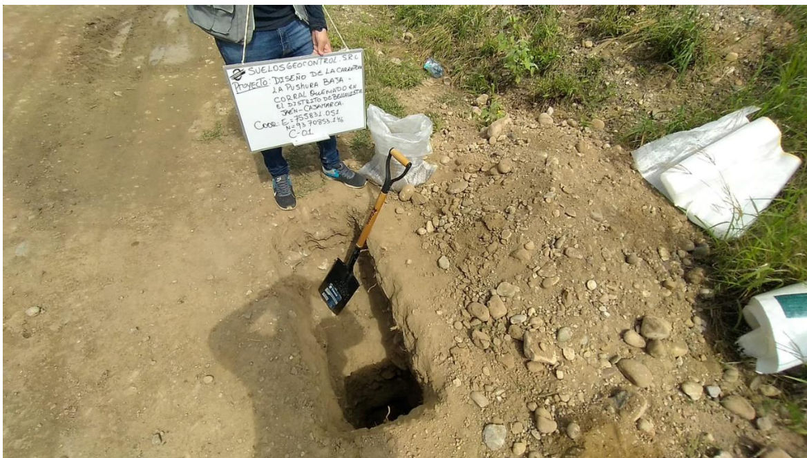
Fotografía 33: Panorama a cielo abierto de los estratos de la calicata N°01 – KM. 0+000
