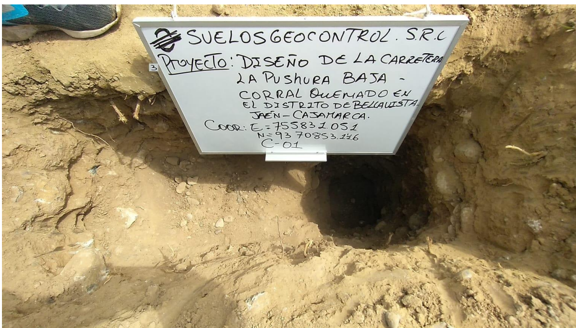
Fotografía 34: Panorama a cielo abierto de la calicata N°01 – KM. 0+000
