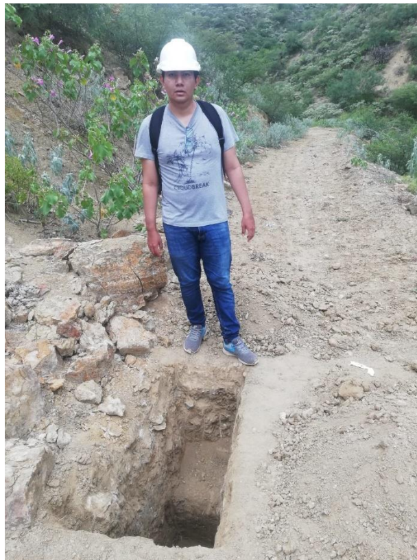
Fotografía 44: Panorama a cielo abierto de la calicata N°06 – KM. 5+000
