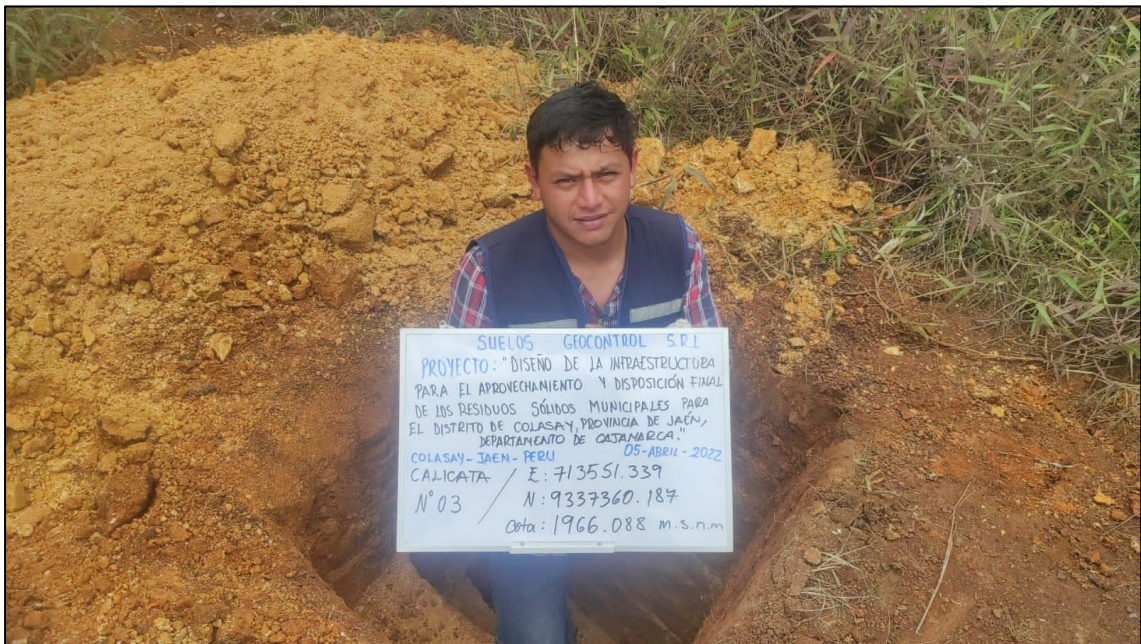
Foto 9. Calicata N°3 - Estudio de mecánica de suelos
