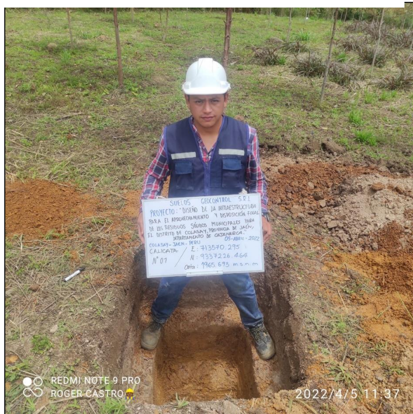
Foto 7. Calicata N°1 - Estudio de mecánica de suelos
