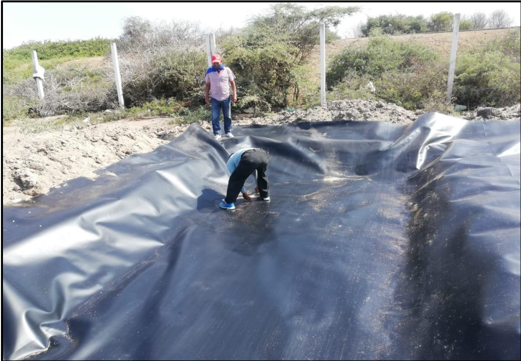
Fotografía 19: Colocación de la geomembrana HDPE de 1mm.
