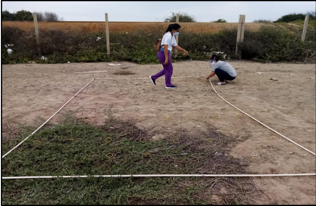
Fotografía 34: Elaboración de un sistema de macrófita flotantes.
