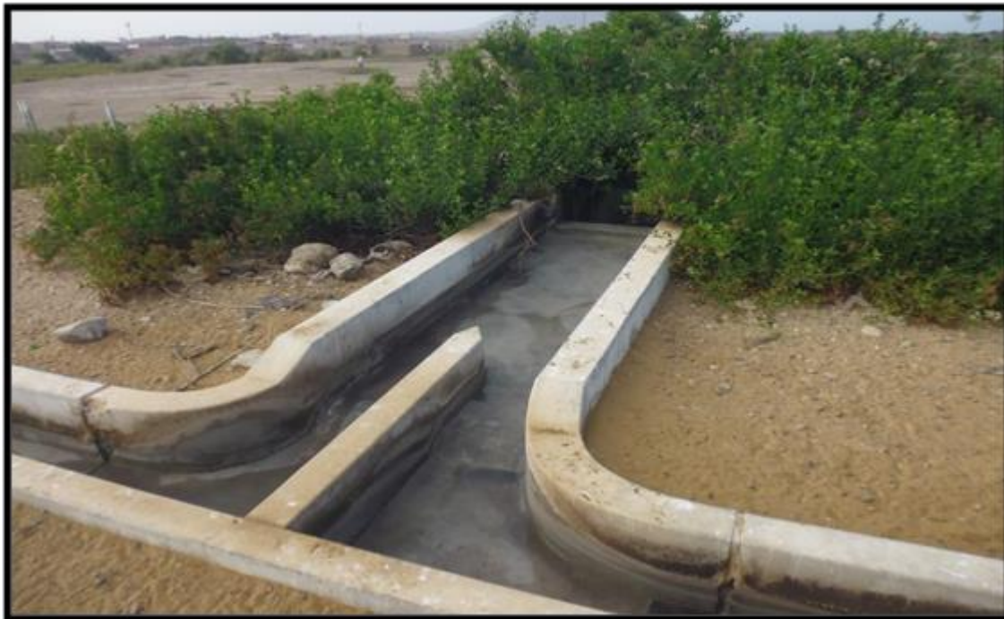
Fotografía 3: Ramales que llevan el agua desde la cámara de bombeo hacia las lagunas de oxidación.
