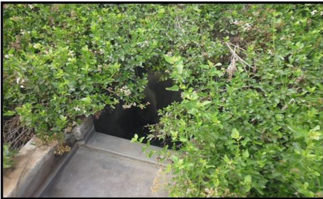
Fotografía 5: Cámara de bombeo de las aguas residuales a las lagunas de oxidación.
