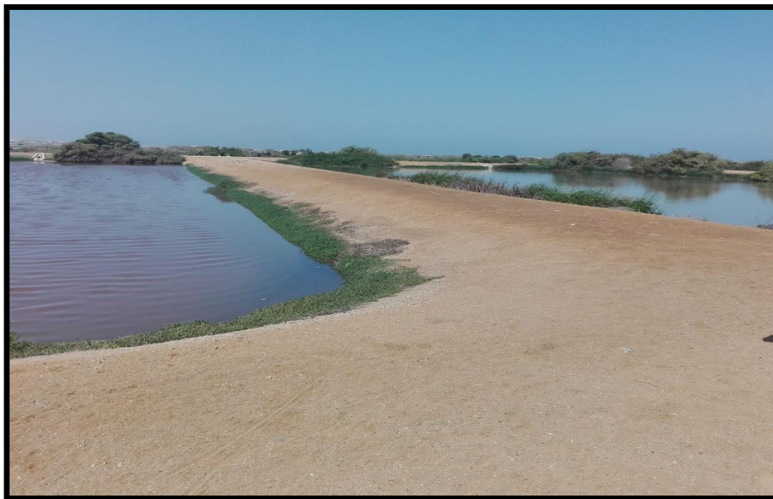
Fotografía 1: Vista general de las lagunas de oxidación de ciudad Eten.
