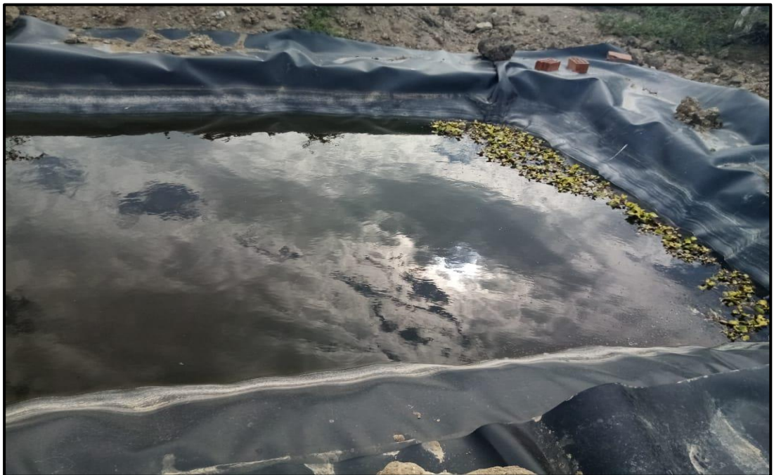
Fotografía 47: Coloración verdosa oscura de los humedales artificiales.
