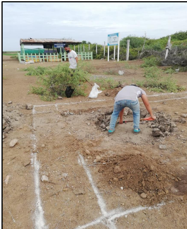
Fotografía 18: Excavación de zanjas para humedales artificiales.
