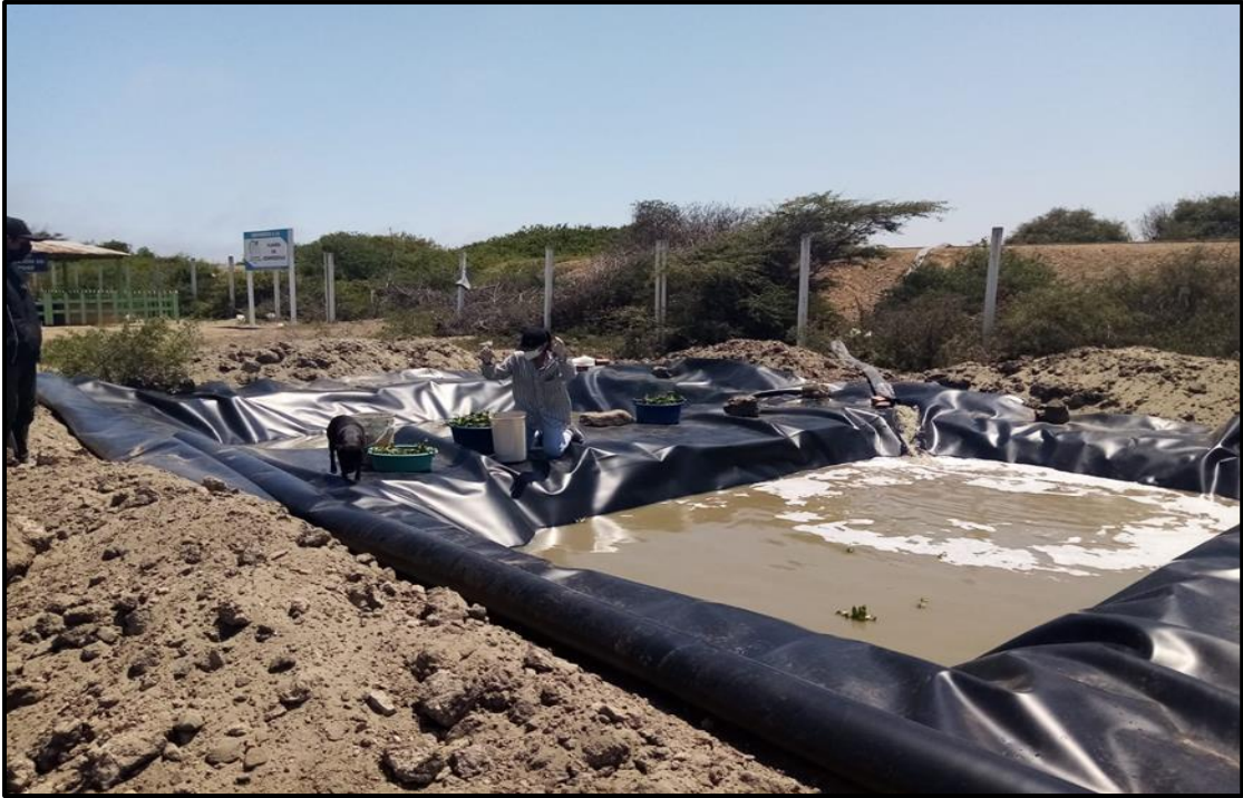
Fotografía 21: Colocación de las plantas acuáticas en ambos humedales.
