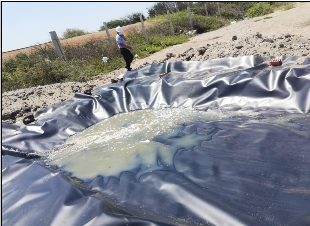
Fotografía 20: Derivación de las aguas residuales de la laguna de control hacia los humedales.
