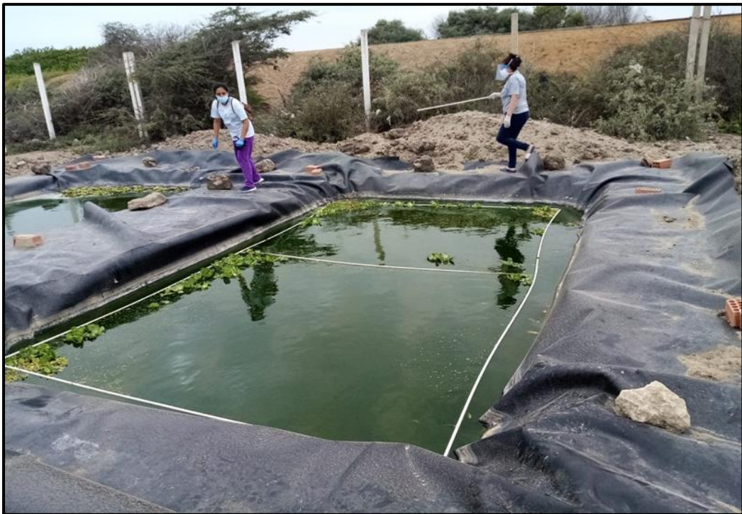
Fotografía 35: Colocación del sistema de macrófitas flotantes, colocado en el humedal con lechugas de agua.
