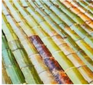
Imagen 177: Tarimas de pavimento de bambú.
