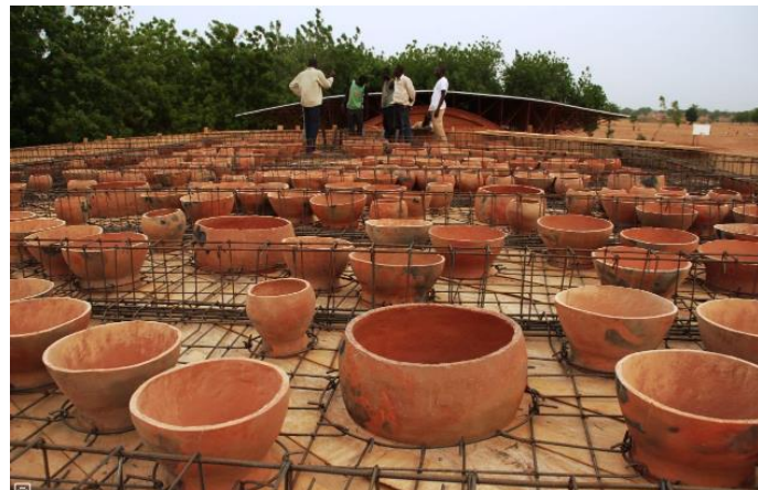
Imagen 31: Proceso constructivo de la cubierta a través de macetas de barro. Fuente: Archdaily Perú.
