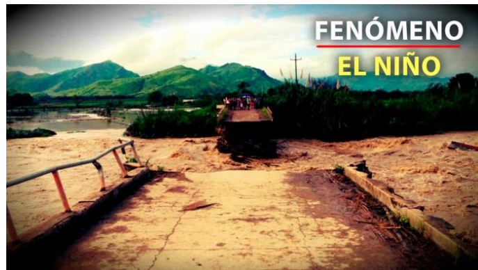
Imagen 99: Destrucción de infraestructura por el Fenómeno El Niño. Fuente: RPP Noticias.
