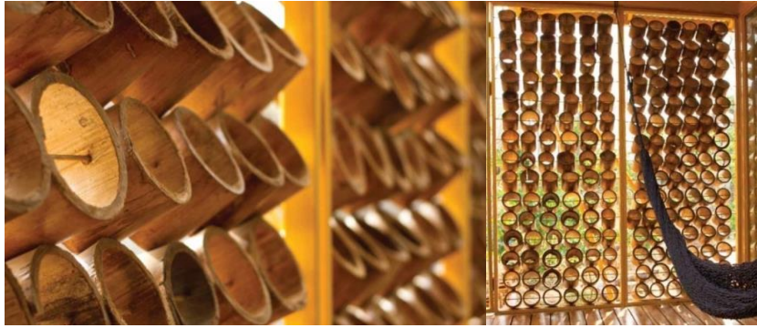
Imagen 208: Cerramiento de conos de bambú. Fuente: Casa de la señora luna, Arq. Benjamín García.
