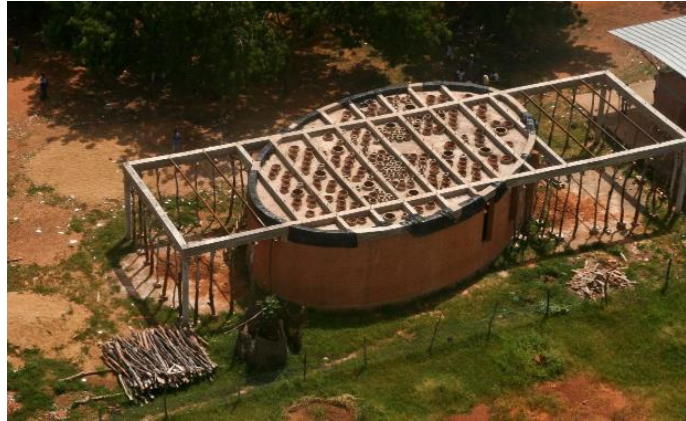
Imagen 32: Vista del proceso constructivo de la biblioteca. Fuente: Archdaily Perú.
