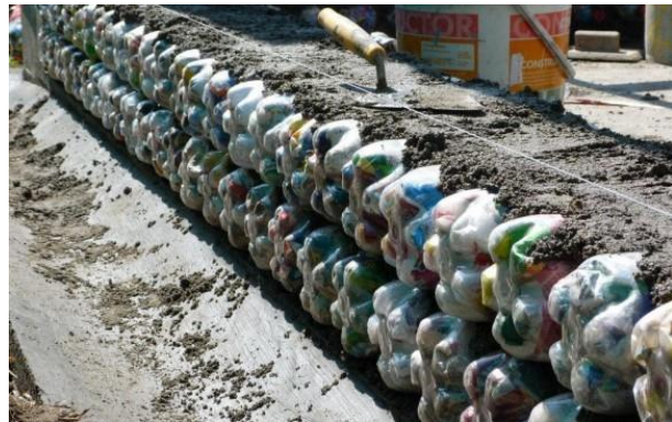
Imagen 210: Construcción de muro de ecoladrillos. Fuente: Proyecto de investigación de estudiantes de la Universidad de Medellín.
