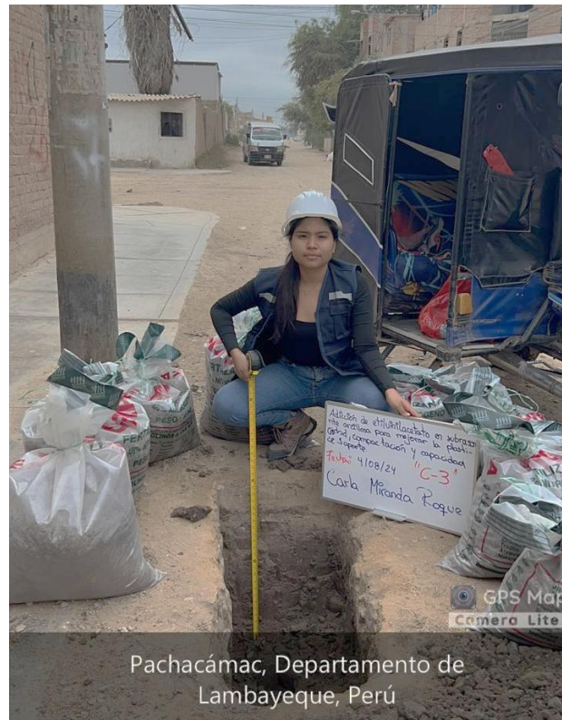
Fig. 8 Extracción de calicatas
