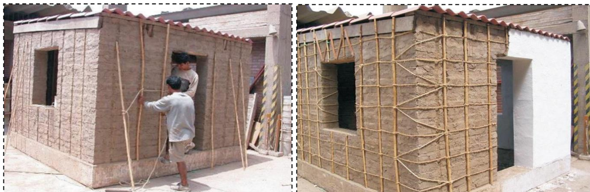
Figura N° 2. Muro de adobe reforzado con malla natural Cabuya
