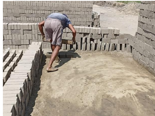
Ilustración 39: Moldeo en la gaberera de 4 ladrillos
