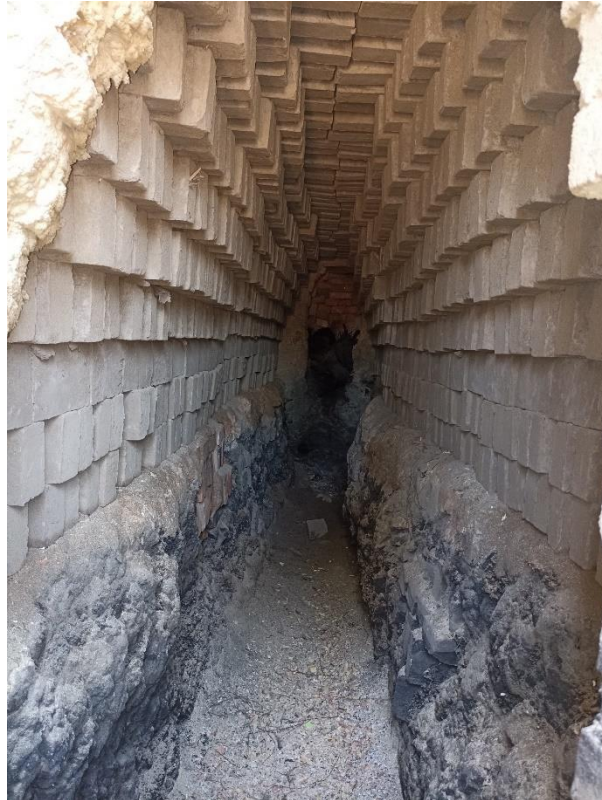
Ilustración 92: Apilado de ladrillos en Horno
