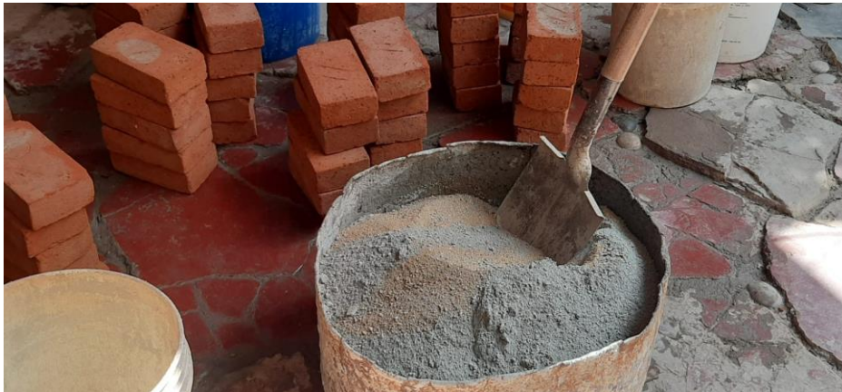
Ilustración 80: Preparación de mezcla de mortero para las pilas
