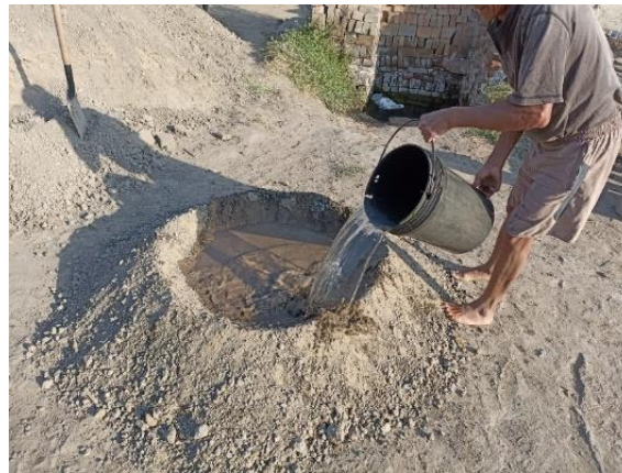
Ilustración 34: Adición de agua a la mezcla
