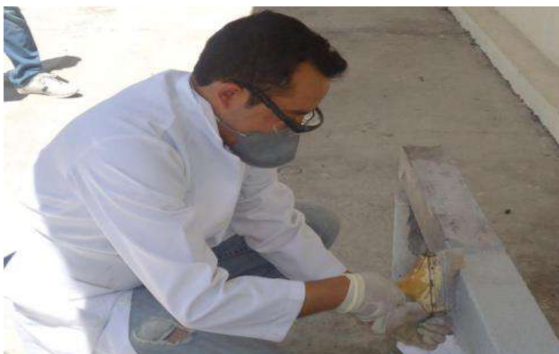
Figura 34: Aplicando la PRFV Sika Wrap100G
