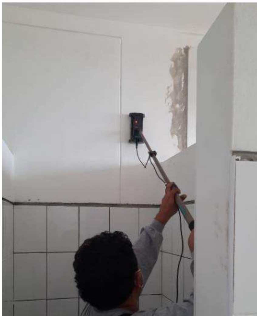
Imagen 32: Escaneo del diámetro del acero longitudinal de la columna EJE D 2-
