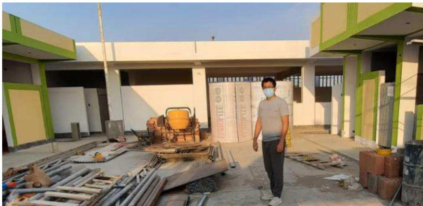
Imagen 10: Vista del aula ubicada en el área asignada al nivel primario-Pabellón 02.
