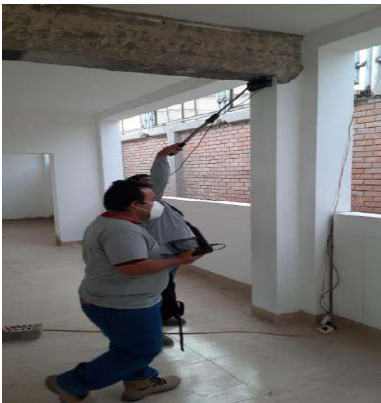
Imagen 26: Escaneo de la columna EJE F 1-
