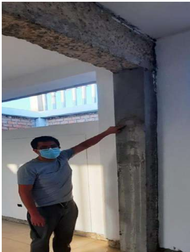
Imagen 17: Columna a la que se realizó uno de los ensayos de diamantina Pabellón B-B.
