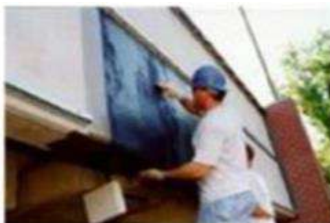
Reforzamiento a Cortante
