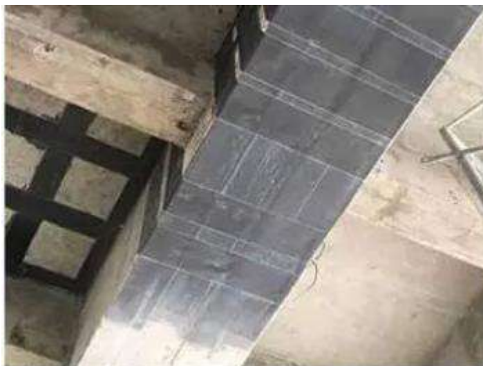
Figura 23: Reforzamiento de viga con CFRP
