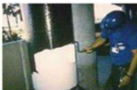
Reforzamiento para Confinamiento
