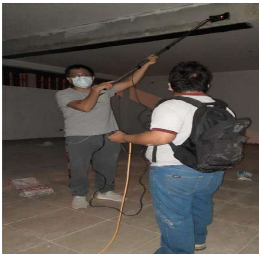
Imagen 35: Escaneo del diámetro del acero longitudinal de la viga EJE F
