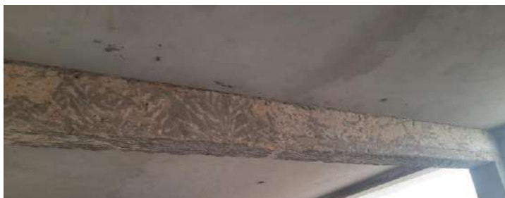
Figura 22: Cincelado de la viga para un previo reforzamiento
