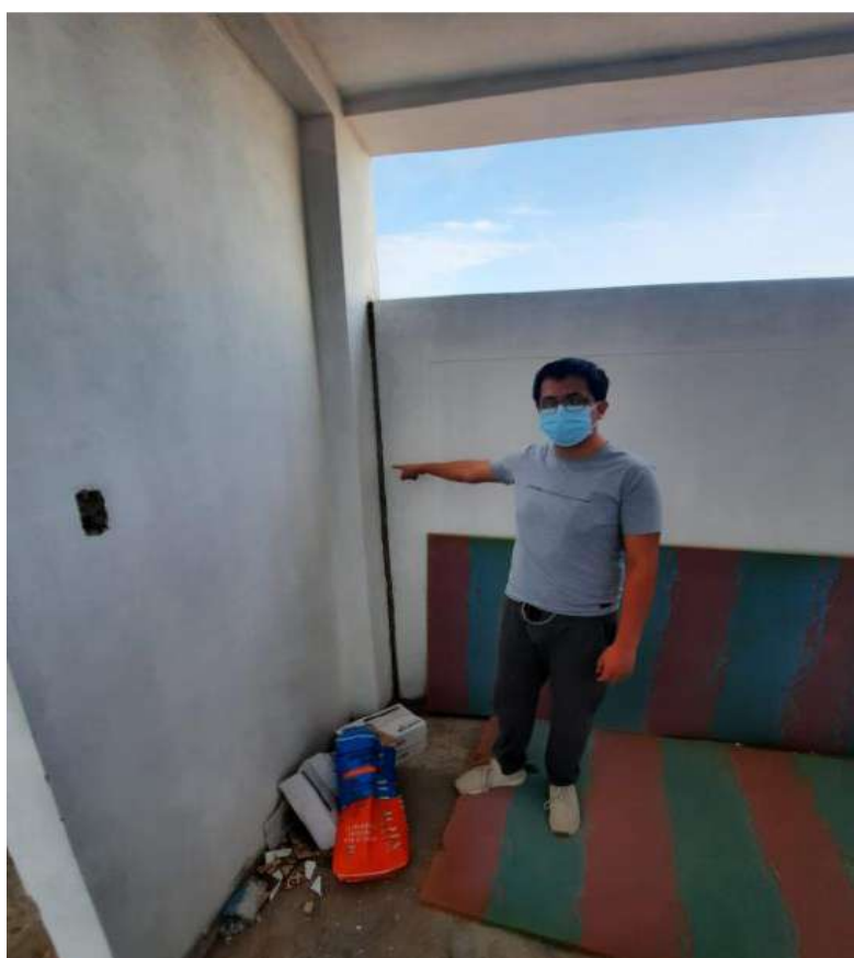
Imagen 14: Vista de separación de la columna con el muro con una junta de 1'' Eje X-X (Pabellón C-C 2do nivel).
