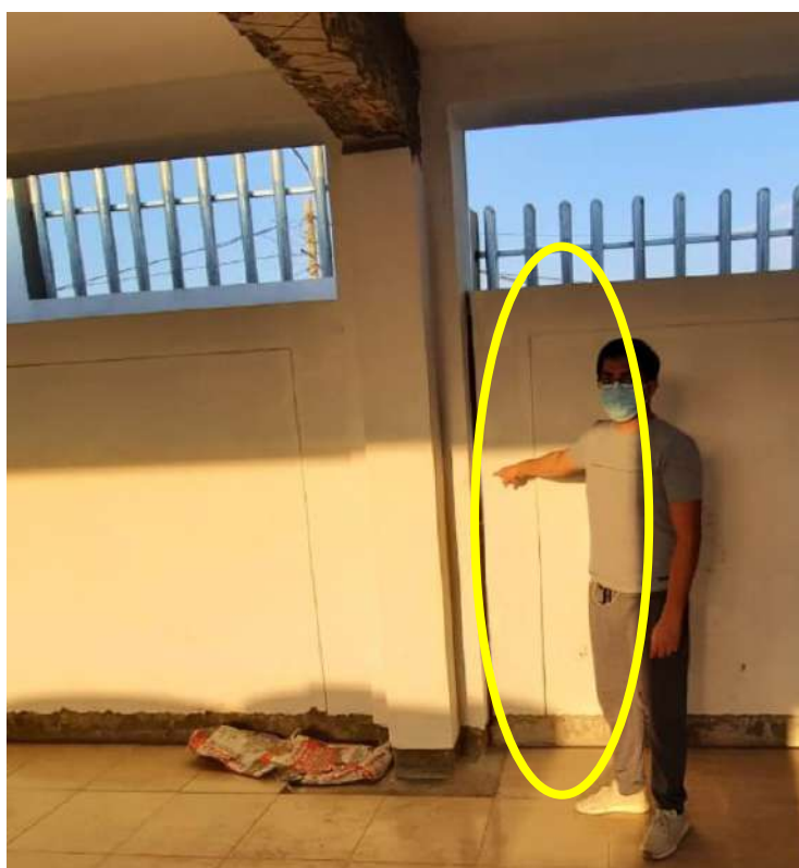
Imagen 12: Vista de separación de la columna con el muro con una junta de 1".
