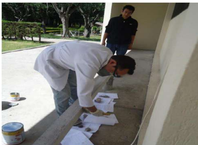
Figura 33: Aplicando la resina
