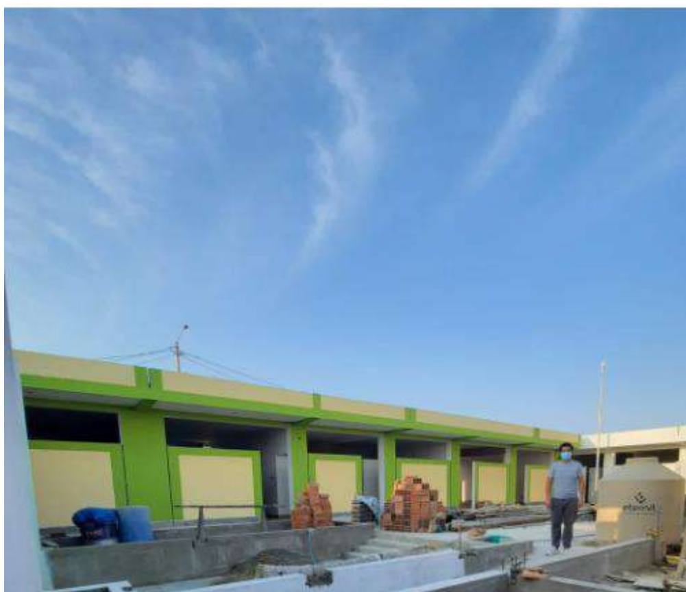
Imagen 8: Vista del aula ubicada en el área asignada al nivel primario-Pabellón 01.
