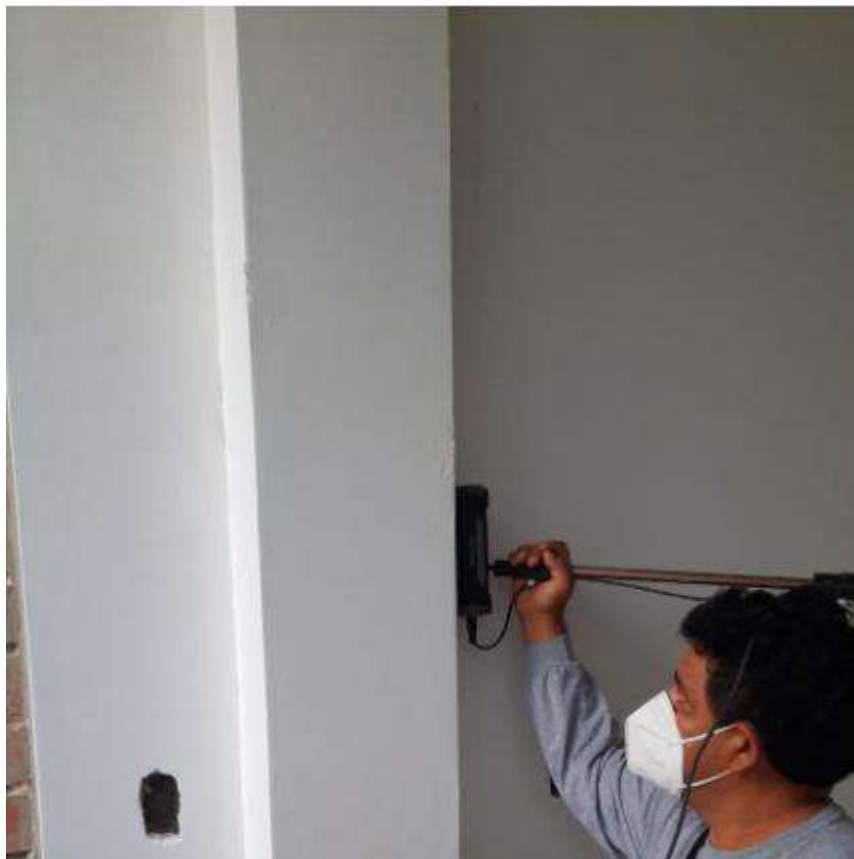
Imagen 38: Escaneo del diámetro del acero longitudinal de la columna EJE 1 H
