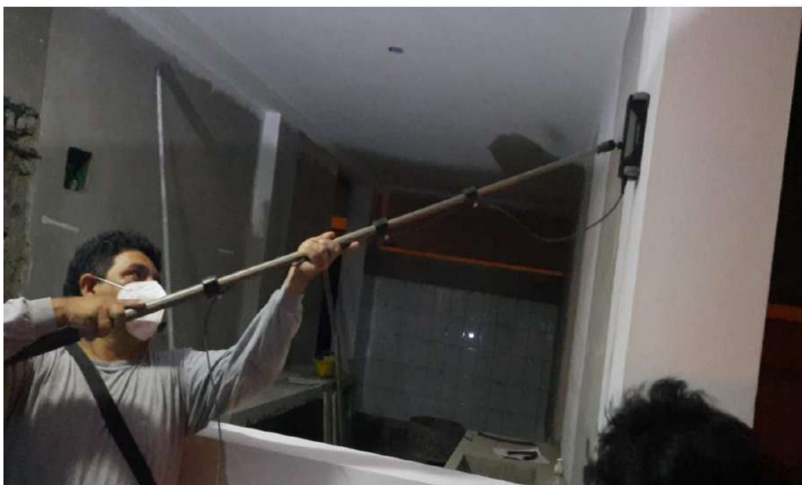
Imagen 49: Escaneo del diámetro del acero longitudinal de la columna EJE K 8
