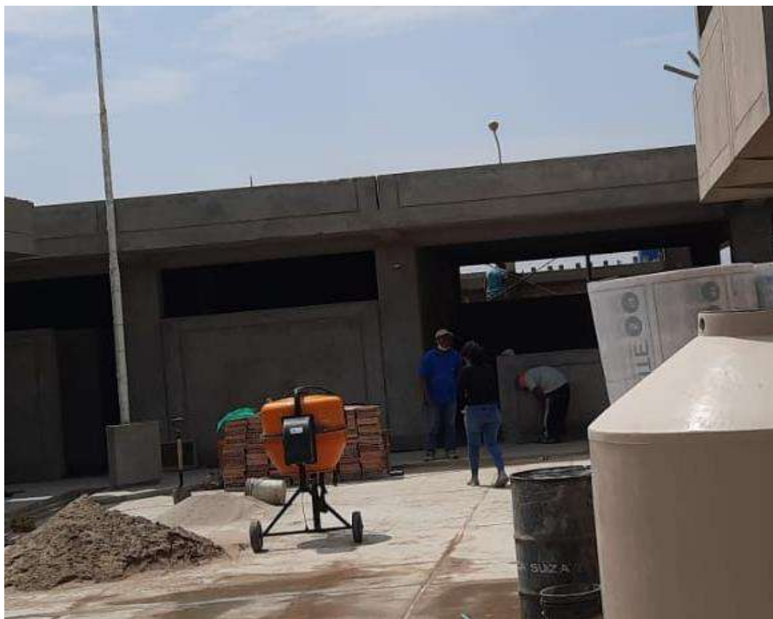
Imagen 9: Vista del aula ubicada en el área asignada al nivel primario-Pabellón 02.
