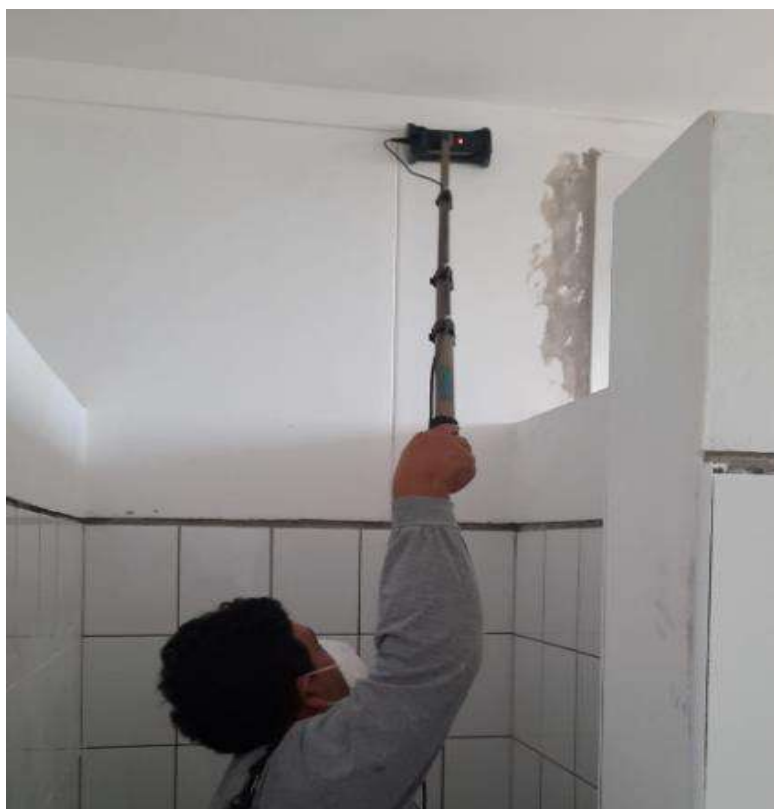
Imagen 31: Escaneo del diámetro del estribo de la columna EJE D 2-
