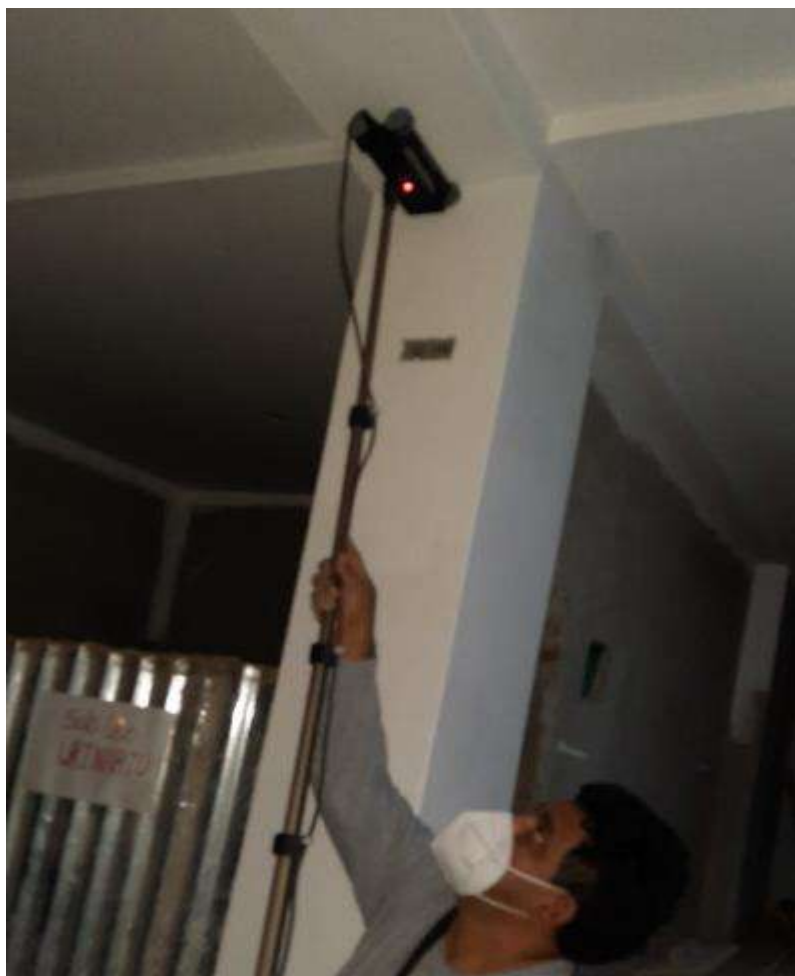
Imagen 52: Escaneo del diámetro del acero longitudinal de la viga EJE L
