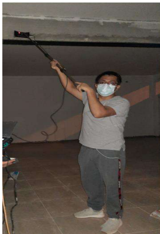
Imagen 51: Escaneo del diámetro del acero longitudinal de la viga EJE L
