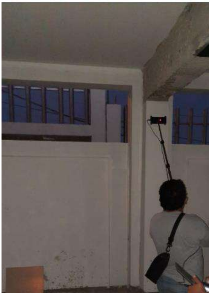
Imagen 39: Escaneo del diámetro del estribo de la columna EJE 6 1-
