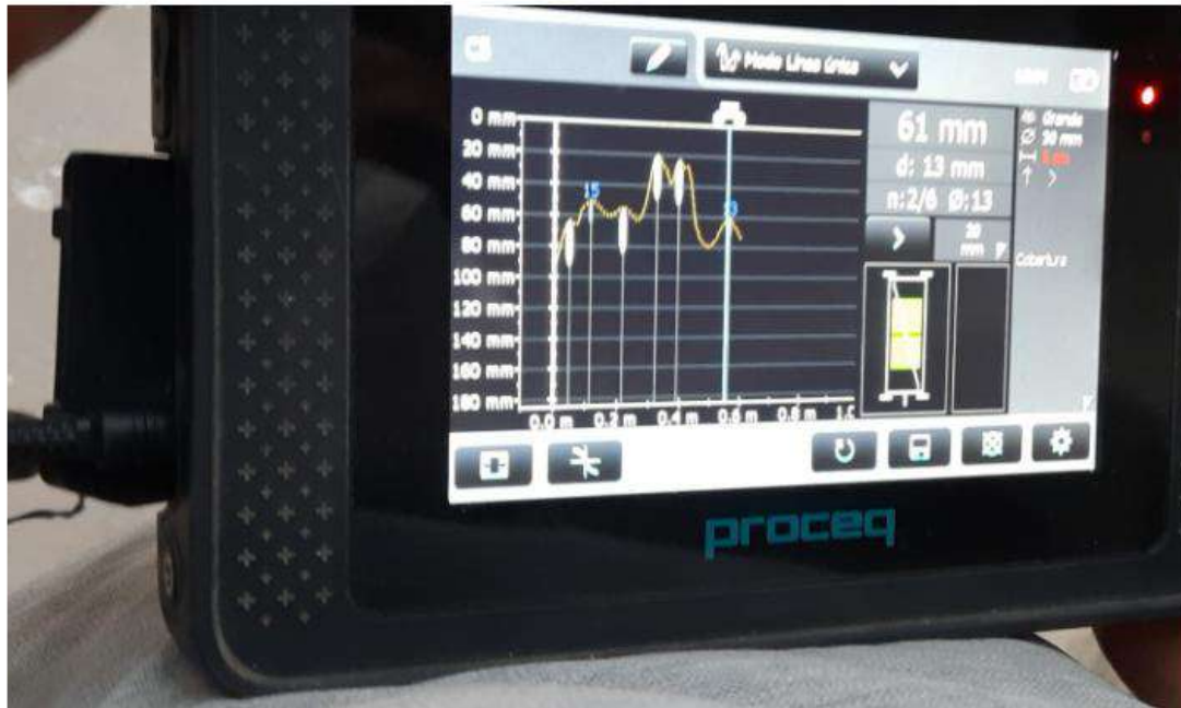
Imagen 37: Escaneo del diámetro del estribo que es de 13mm= 1/2", de la columna EJE 1 H
