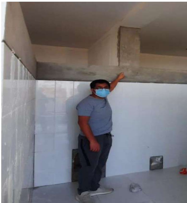
Imagen 20: Columna a la que se realizó un escaneo de acero estructural Pabellón B-B.
