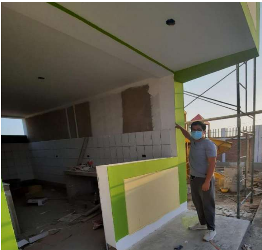
Imagen 13: Columna a la que se realizo un escaneo de acero estructural Pabellón C-C.
