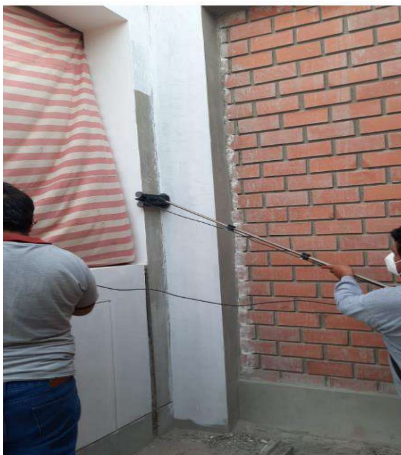
Imagen 24: Escaneo del diámetro del estribo de la columna EJE A 1-
