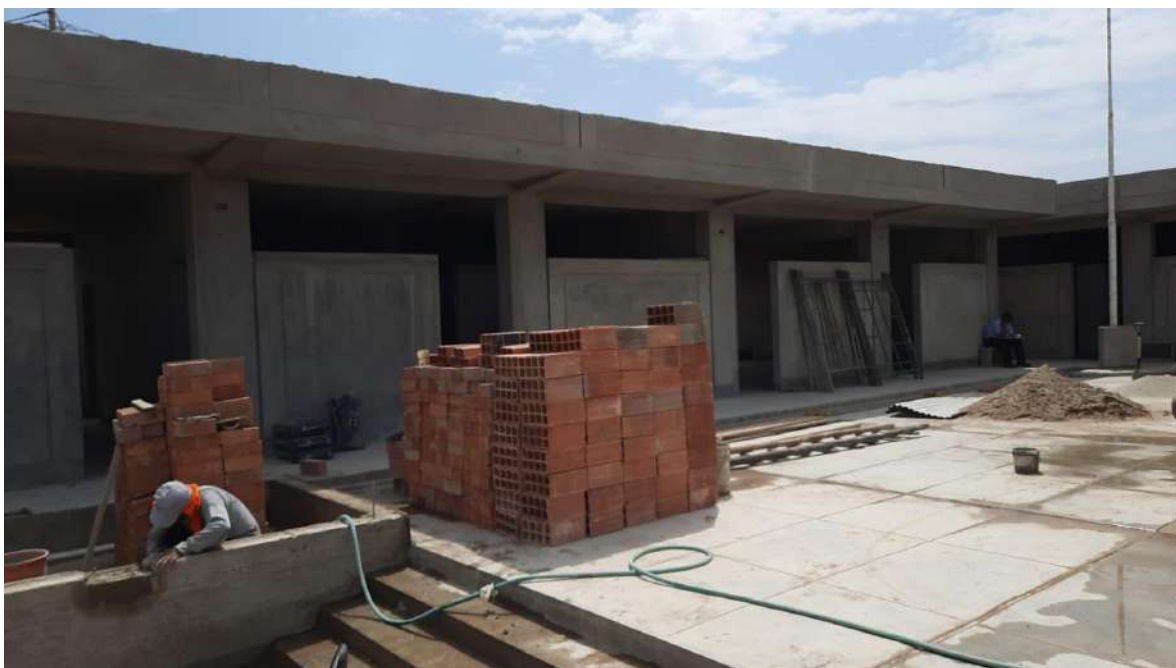
Imagen 7: Vista del aula ubicada en el área asignada al nivel primario-Pabellón 01.
