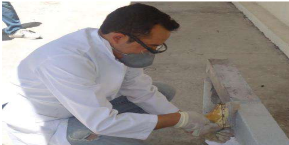
Figura 34: Aplicando la PRFV Sika Wrap100G
