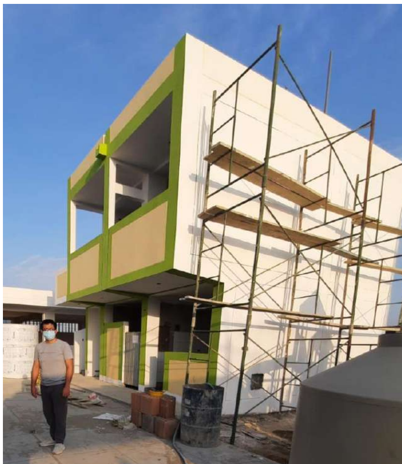
Imagen 11: Vista del aula ubicada en el área asignada al nivel primario-Pabellón 03.
