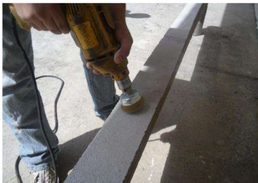
Figura 27: Limpiando la superficie
