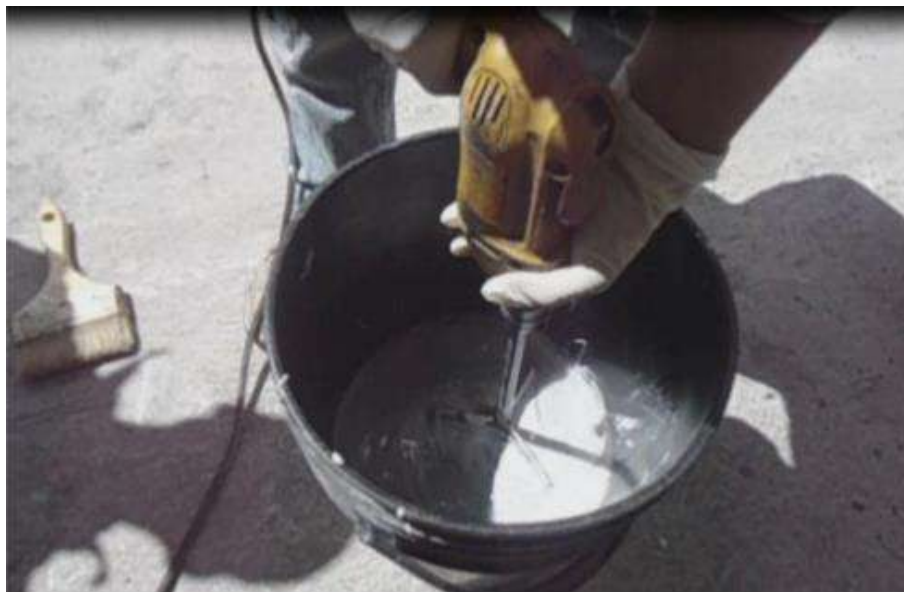
Figura 32: Mezclando los compuestos A y B
