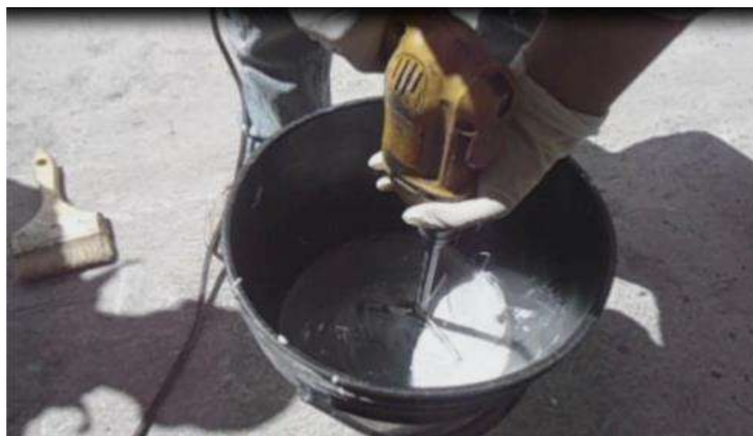
Figura 32: Mezclando los compuestos A y B
