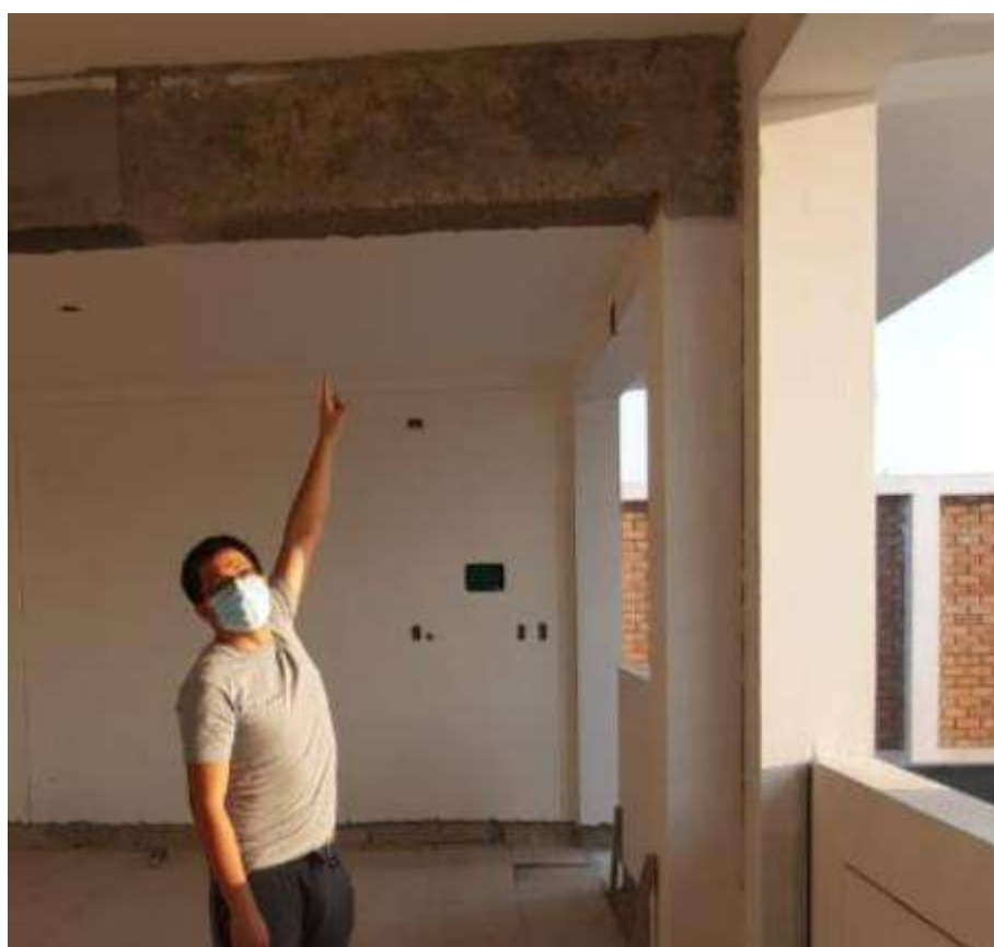
Imagen 16: Viga a la que se realizó un escaneo de acero estructural Pabellón B-B.
