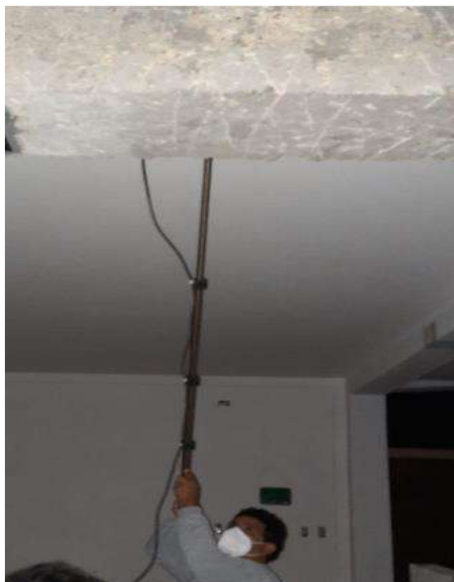
Imagen 44: Escaneo del diámetro del acero longitudinal de la viga EJE 6
