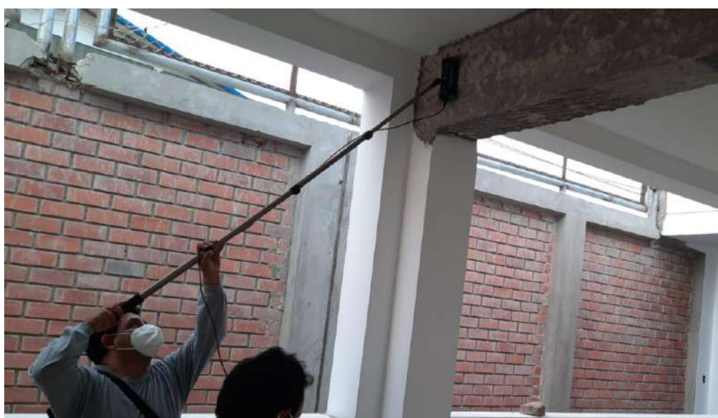
Imagen 33: Escaneo del diámetro del estribo de la viga EJE F
