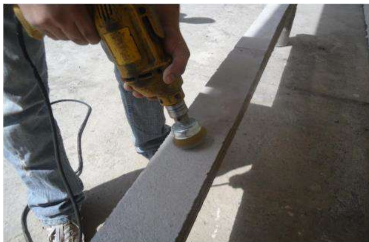
Figura 27: Limpiando la superficie
