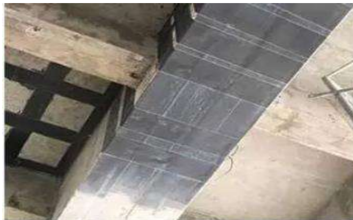
Figura 23: Reforzamiento de viga con CFRP
