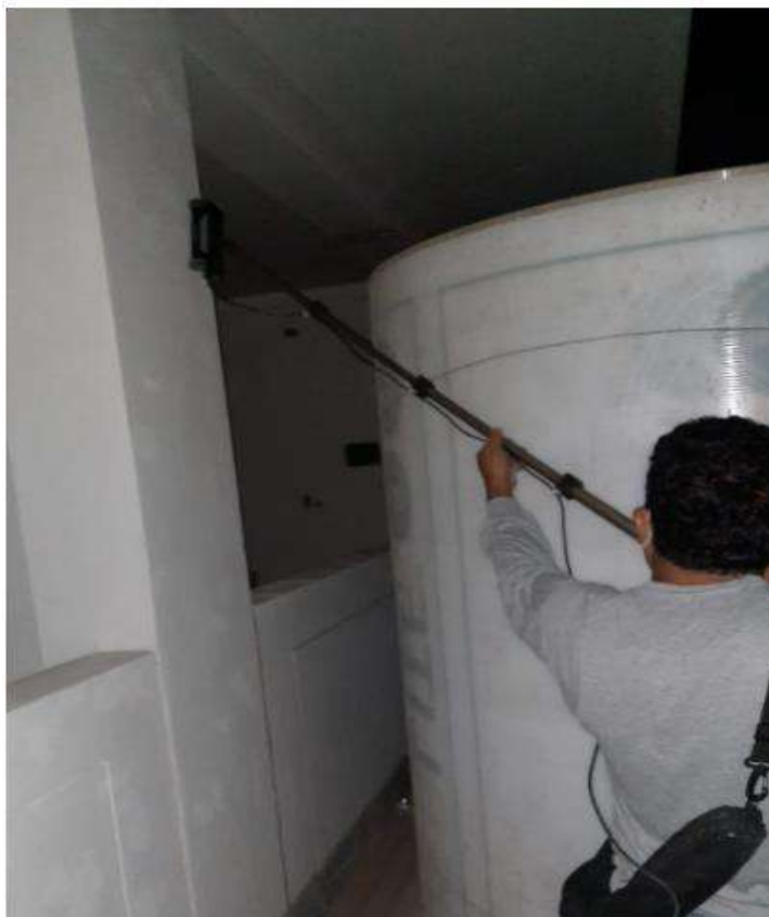
Imagen 41: Escaneo del diámetro del acero longitudinal de la columna EJE 6 1-
