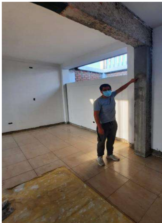
Imagen 18: Columna a la que se realizó uno de los ensayos de diamantina Pabellón A-A.
