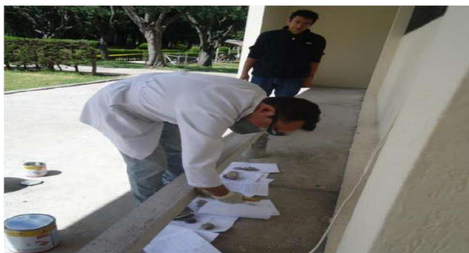
Figura 33: Aplicando la resina
