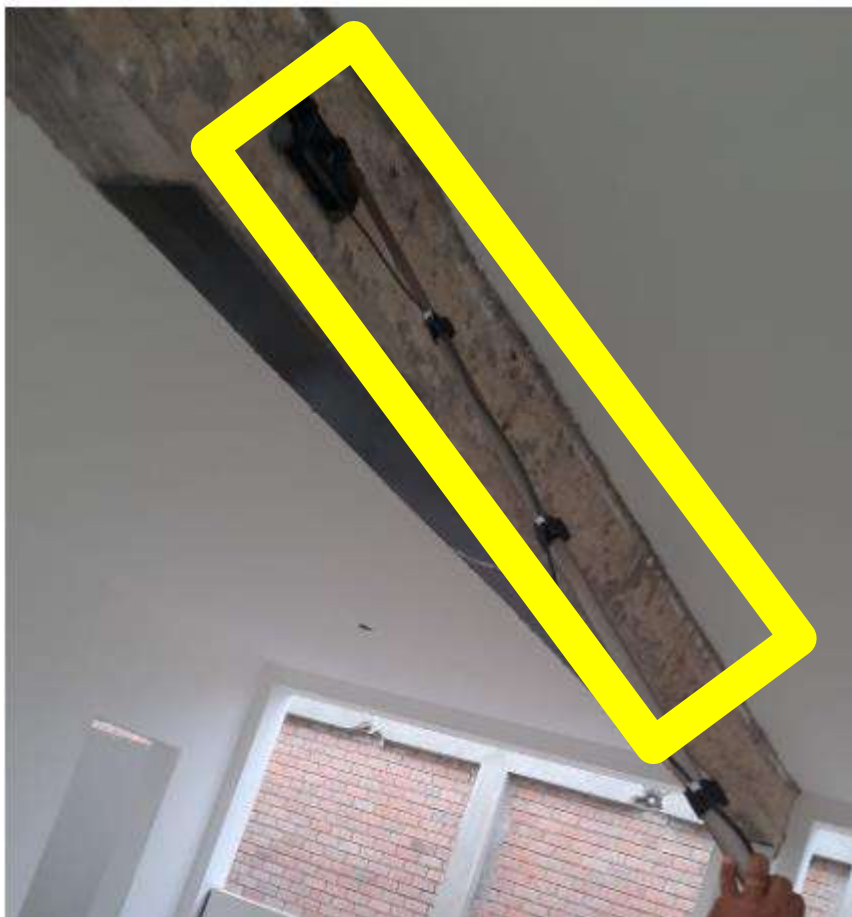
Imagen 34: Escaneo del diámetro del acero longitudinal de la viga EJE F
