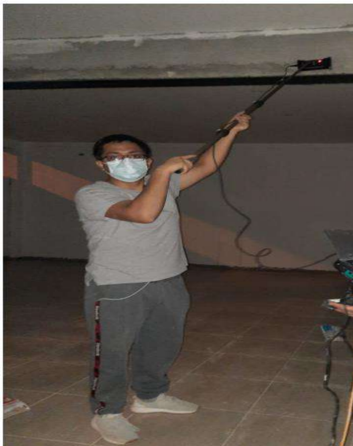
Imagen 43: Escaneo del diámetro del acero longitudinal de la viga EJE 6
