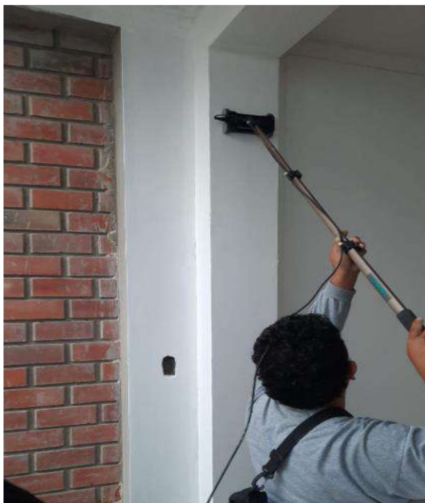
Imagen 36: Escaneo del diámetro del estribo de la columna EJE 1 H
