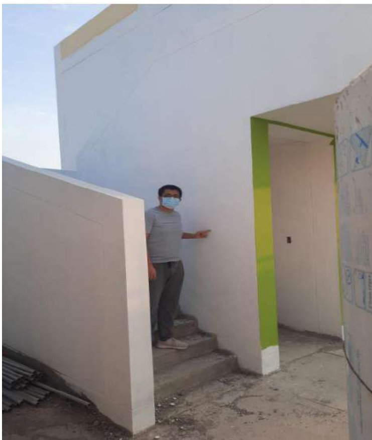
Imagen 21: Vista de la placa en la cual la escalera se apoya Pabellón C-C.
