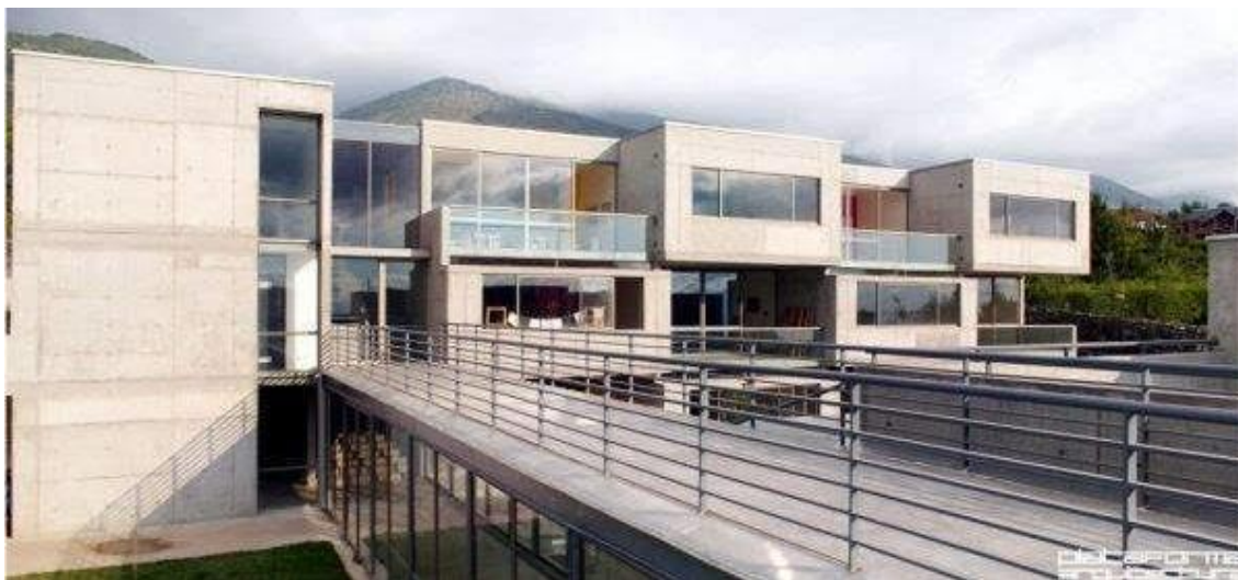
Imagen 09: Interior del Colegio Epullay Montessori. Fuente: Plataforma Arquitectura.
