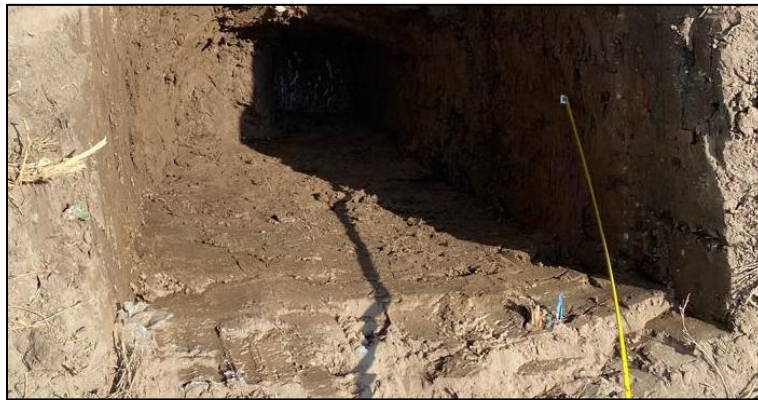
Profundidad ce la C-03
