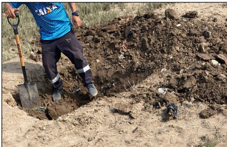
Excavación de la calicata C-01
