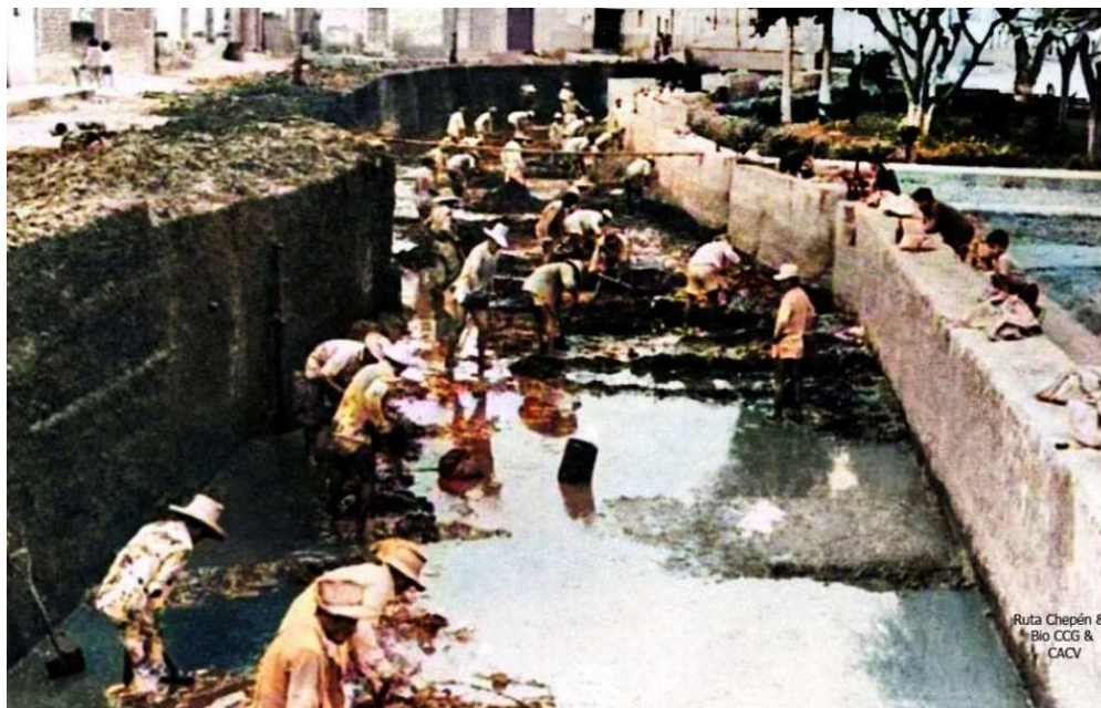
Figura 02: Obras de canalización de la Acequia Lurifíco.
