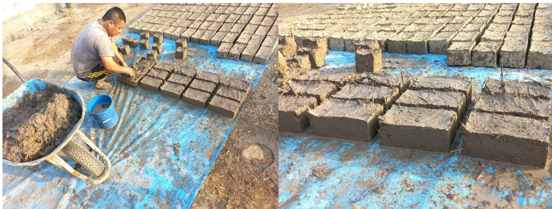
Figura 53. Encofrado y desencofrado de las muestras de adobe de paja
