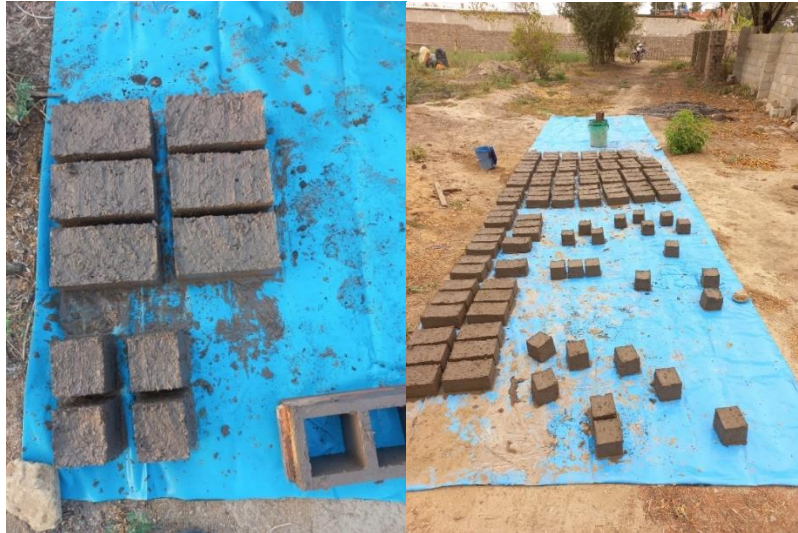
Figura 52. Encofrado y desencofrado de las muestras hechas con viruta
