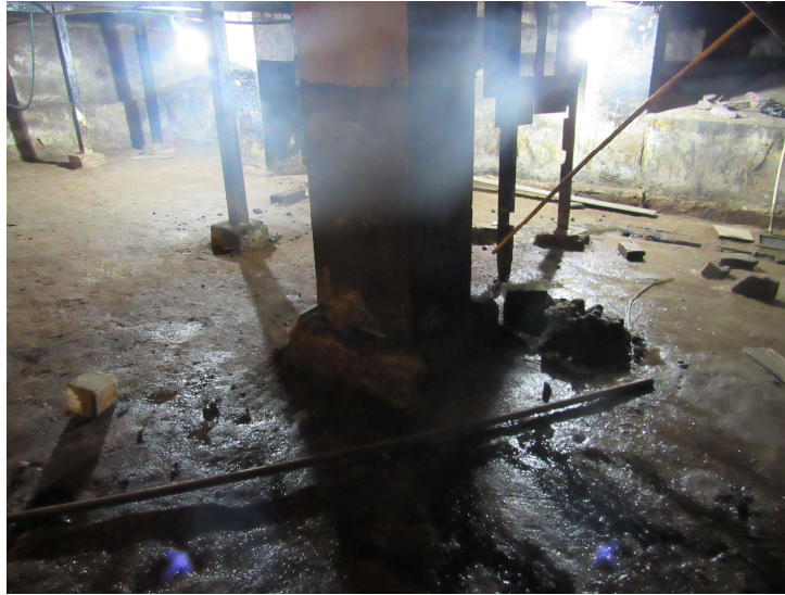
Figura 54: Lesión abiótica, que corresponde a la filtración de la capa freática en la parte de abajo del escenario
