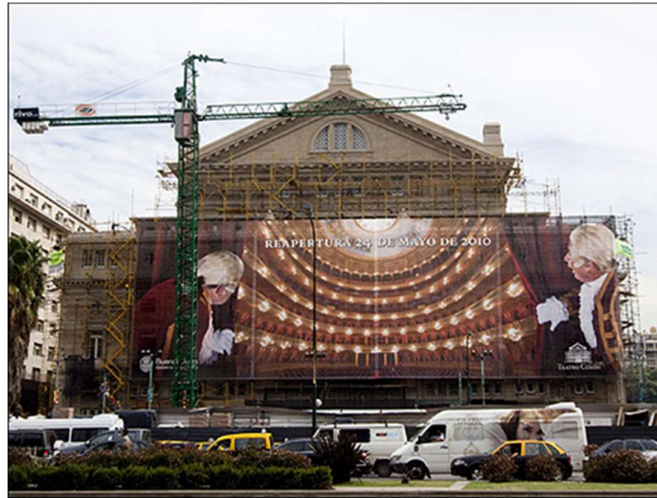
Figura 22: Trabajos de fachada en el Teatro Colon.
