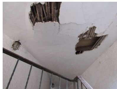
Figura 59: Desprendimiento de revoque en paredes y techos, Chiclayo, 2019
