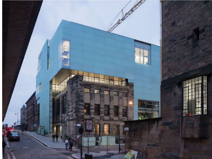
Figura 36: Intervención, que se diferencia del original.
