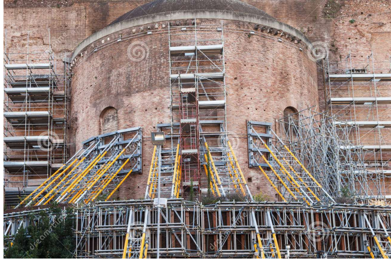
Figura 32: Consolidación de un muro para evitar su derrumbe.
