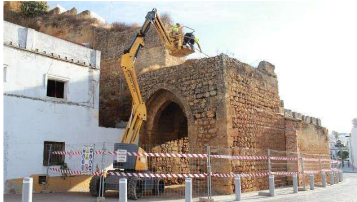
Figura 33: Se recogen las piezas derrumbadas y se colocan en su mismo sitio.
