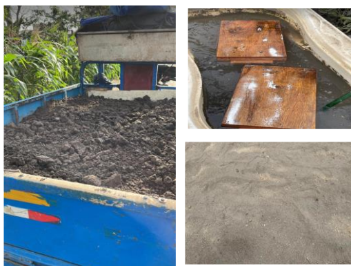
IMAGEN N°24: Extracción y traslado de materiales necesarios para realizar bloques convencionales.
