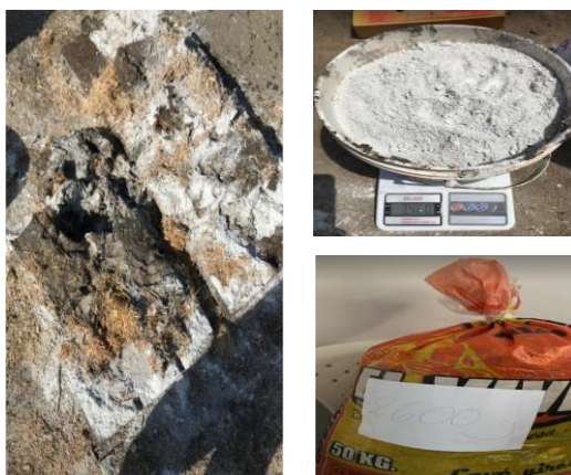
IMAGEN N°29: Hidratación previa y mezclado de los materiales para elaborar bloques estabilizados.
