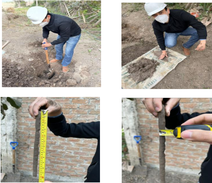
IMAGEN N°12: Realización de la prueba de cinta de barro.
