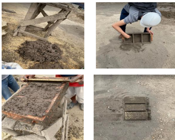
IMAGEN N°26: Proceso de moldeado y desencofrado para las unidades convencionales
