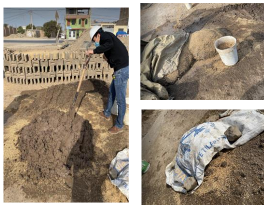
IMAGEN N°25: Proceso de hidratación previa para homogenizar la mezcla.
