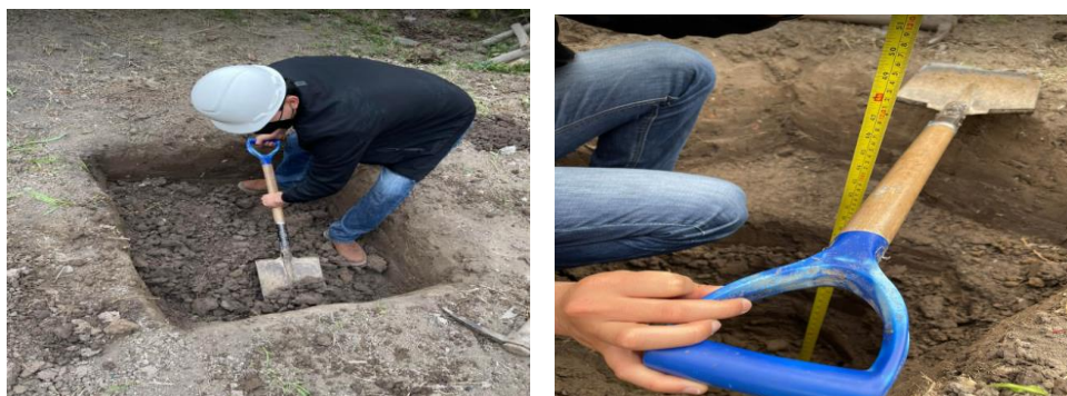
IMAGEN N°15: Realización de calicata para estudios de suelos.
