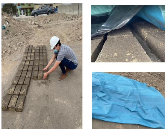
IMAGEN N°27: Proceso de moldeado y desencofrado para las unidades convencionales
