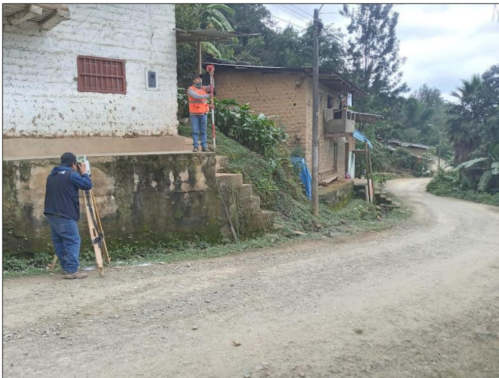
Fotografía 7. Lectura de puntos de viviendas aledañas
