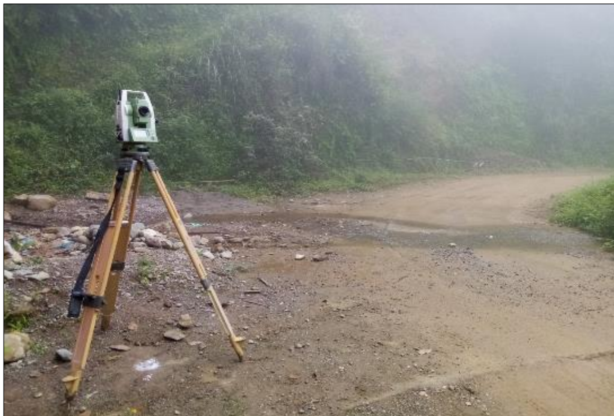
Fotografía 16. Levantamiento topográfico en quebrada Pusmalca
