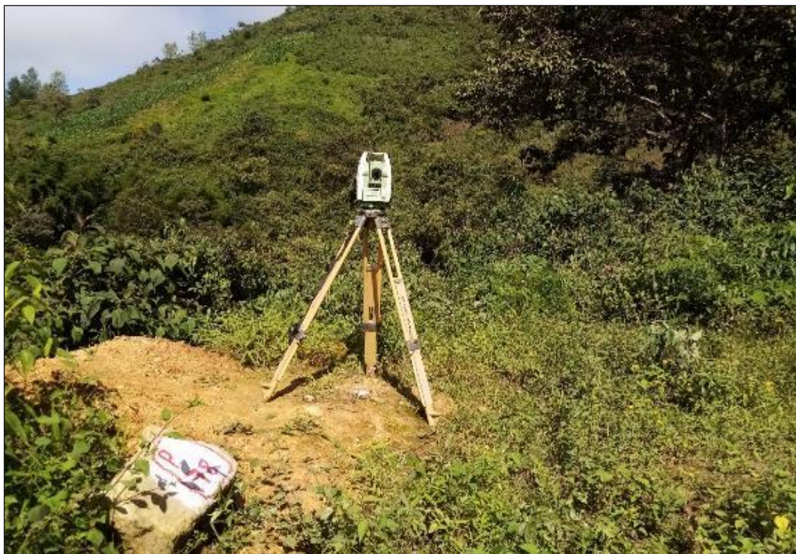
Fotografía 11. Ubicación del P-78 de la poligonal de apoyo
