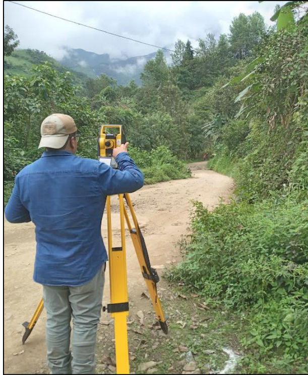
Fotografía 67. Pendiente pronunciada en Km 6+210
