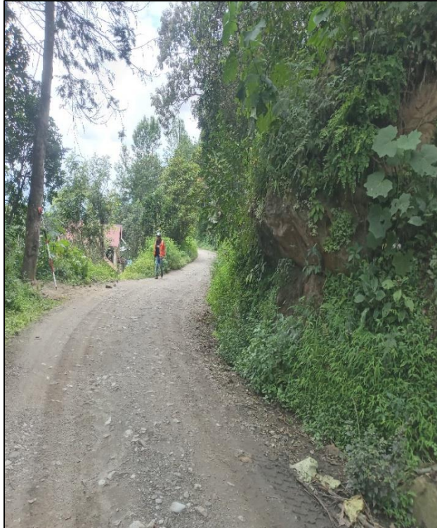
Fotografía 69. Curva pronunciada de radio 14m en Km 10+220
