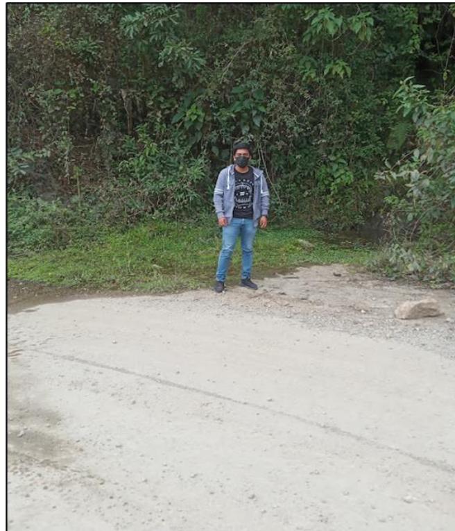
Fotografía 60. Presencia de quebrada en Km 6+370
