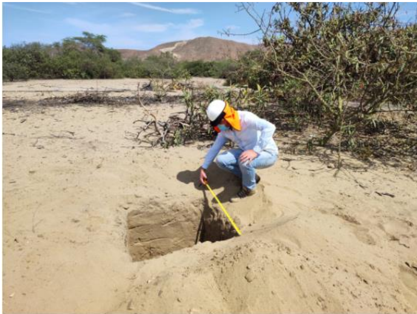
Fotografía N°8: Toma de medida de la calicata C-1
