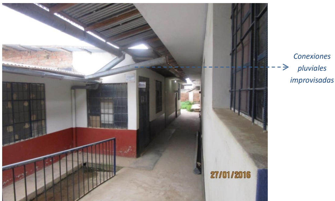
Imagen 8: Identificación de drenaje pluvial
