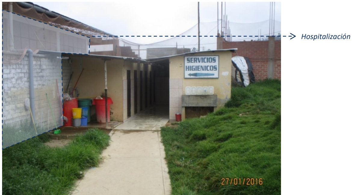
Imagen 18: Zona de servicios higiénicos
