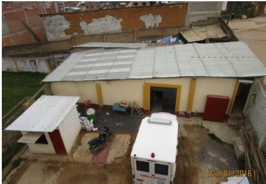
Imagen 10: Condiciones actuales de sub estación
