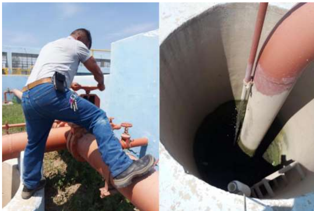
Figura 6. Toma de muestra del efluente
