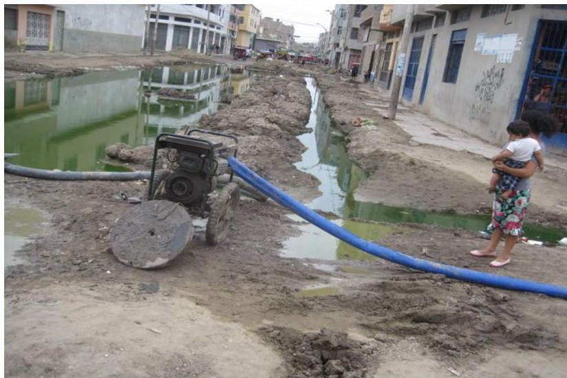
Figura 2: Familias afectadas debido al colapso del desagüe del distrito de José Leonardo Ortiz.
