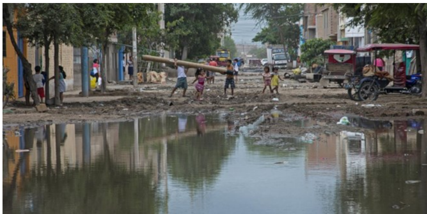
Figura 1: Viviendas colapsadas por las lluvias emergencia sanitaria
