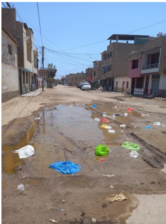
Figura 8: Intersección de calle Panamá con Lindon Jonhson
