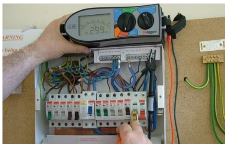
Figura 15: Tableros de control eléctrico
