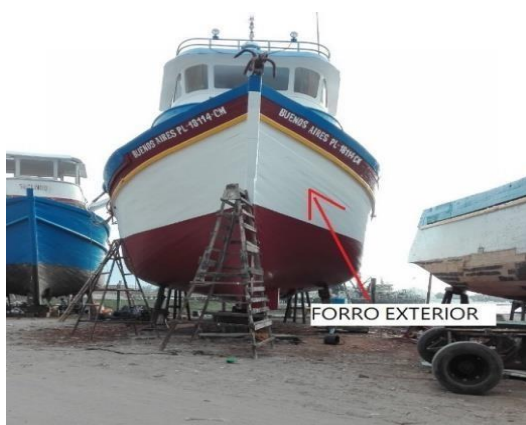
Figura 9: Forro exterior de la embarcación
