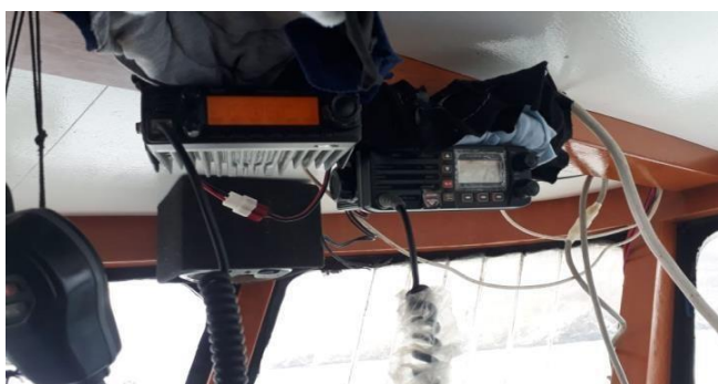
Figura 23: Equipos de comunicación localizados dentro de la caseta
