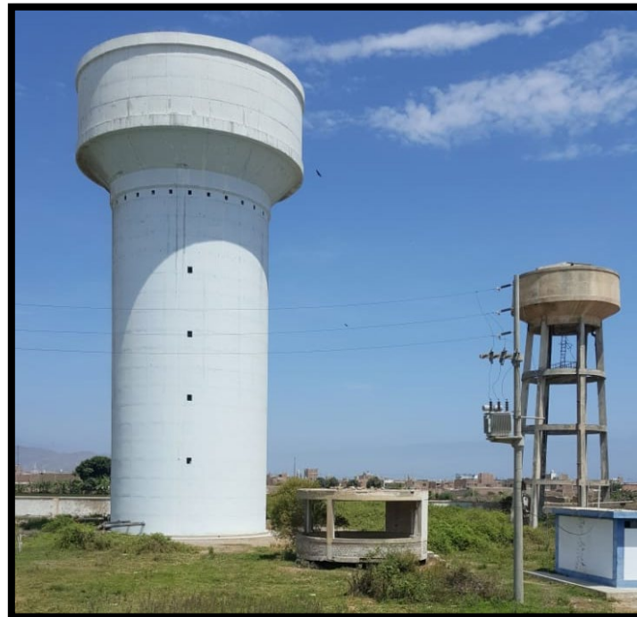
Imagen N° 08: Tanque elevado (volumen: 430m 3 )
