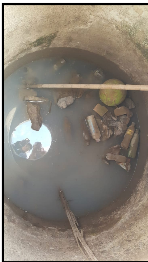
Imagen N° 10: Buzones que colapsan en tiempos de lluvias (señalados por los pobladores)
