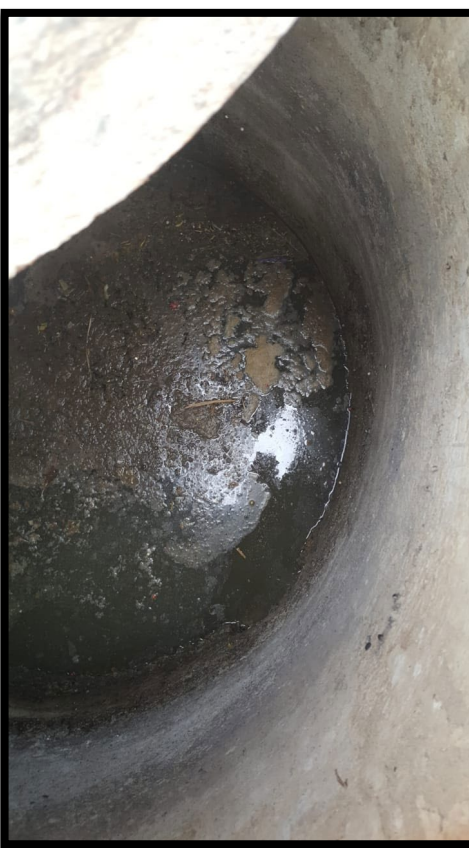
Imagen N° 10: Buzones que colapsan en tiempos de lluvias (señalados por los pobladores)
