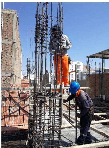
Figura 51 Trabajo Productivo en la partida de Acero Columnas
