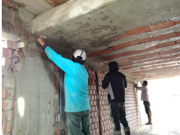
Figura 116 Trabajo Contributorio en la Partida de Tarrajeo de Losa
