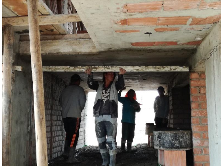
Figura 114 Trabajo Productivo en la partida de Tarrajeo de Losa Fuente: Elaboración propia
