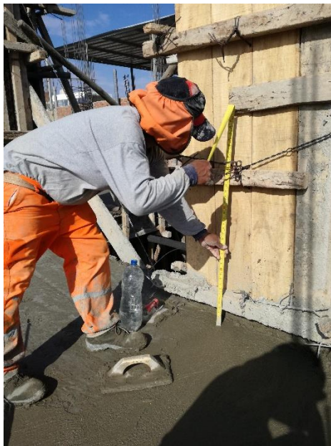
Figura 88 Trabajo Contributorio en la Partida de Concreto Losa Fuente: Elaboración propia
