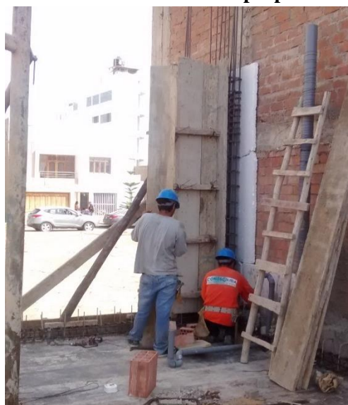
Figura 27 Trabajo Productivo en la partida de Encofrado de Columnas Fuente: Elaboración propia
