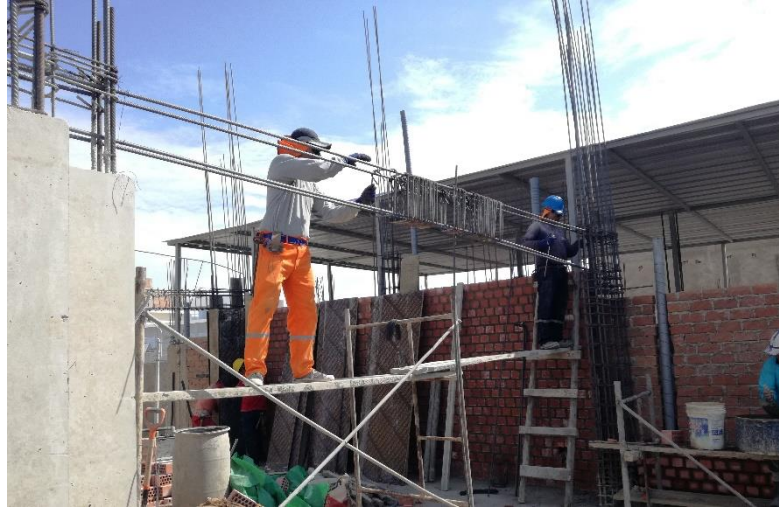
Figura 59 Trabajo Productivo en la partida de Acero Vigas
