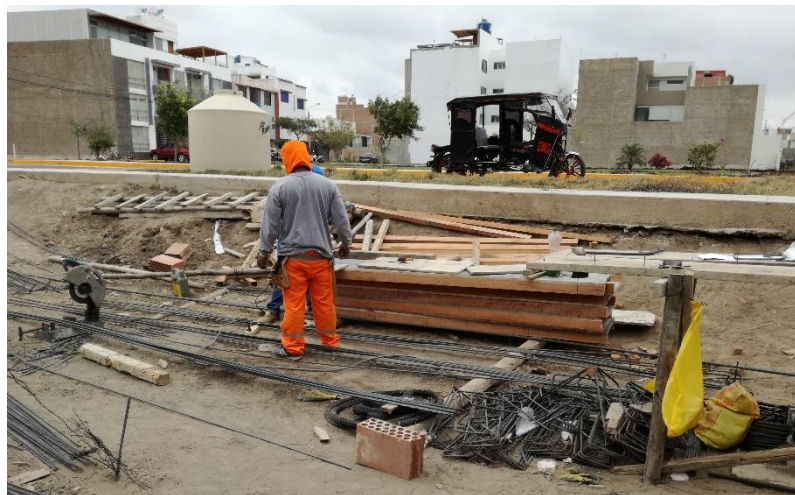
Figura 13 Trabajo Contributorio Encofrado de Vigas de Cimentación Fuente: Elaboración propia
