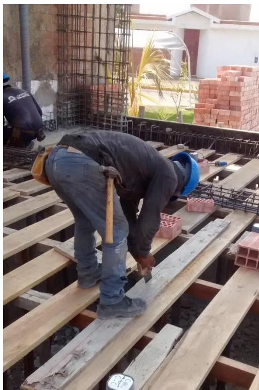
Figura 29 Trabajo Contributorio en la partida de Encofrado de Columnas
