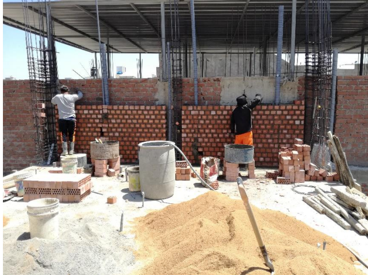
Figura 98 Trabajo Productivo en la Partida de Asentado de Muros de Ladrillo Fuente: Elaboración propia
