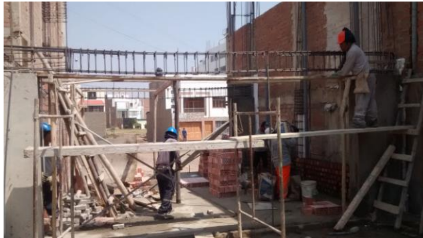
Figura 35 Trabajo Productivo en la Partida de Encofrado de Vigas
