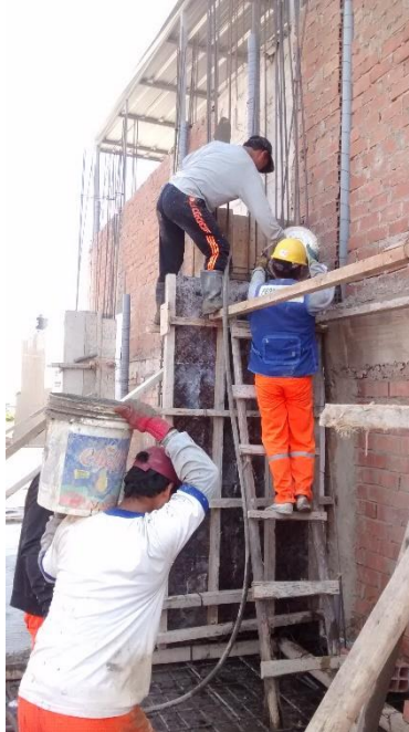
Figura 75 Trabajo Productivo en la partida Concreto Columnas
