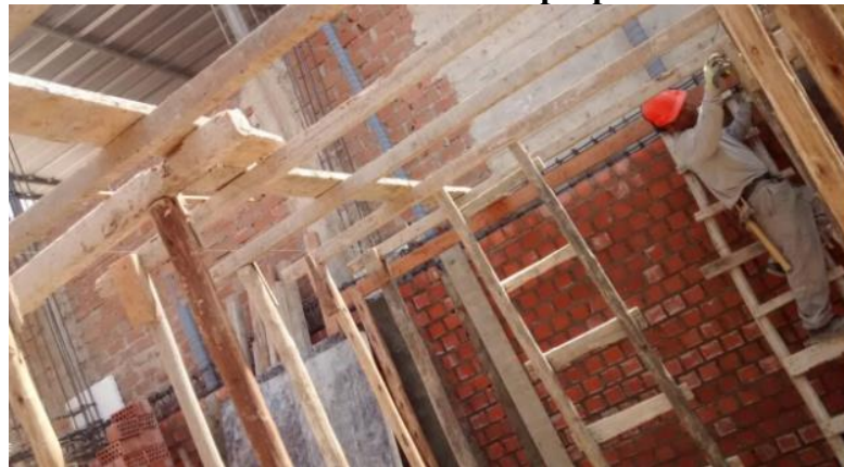
Figura 43 Trabajo Productivo en la partida de Encofrado de Losa.
