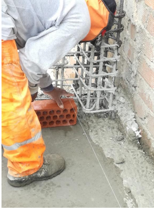
Figura 100 Trabajo Contributorio en la partida de Asentado de Muros de Ladrillo
