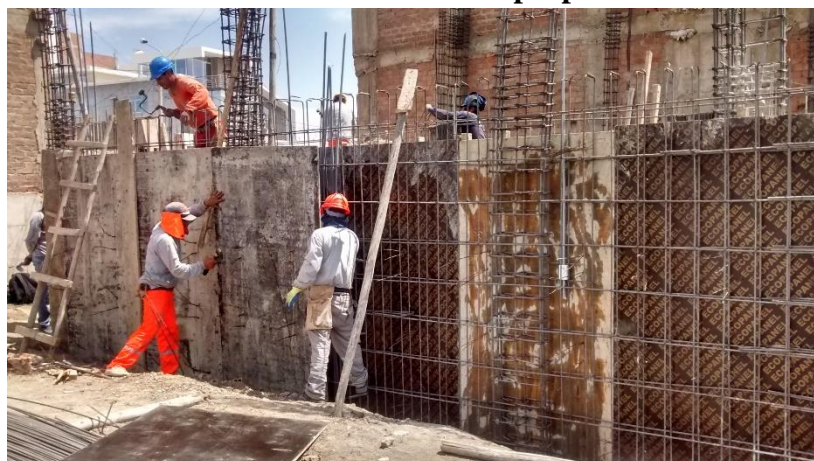
Figura 19 Trabajo Productivo en la Partida de Encofrado Muros de Sótano Fuente: Elaboración propia
