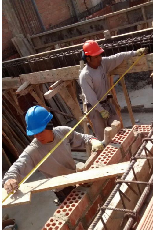
Figura 37 Trabajo Contributorio en la partida de Encofrado de Vigas
