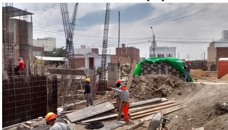
Figura 21 Trabajo Contributorio en la partida de Encofrado Muros de Sótano Fuente: Elaboración propia
