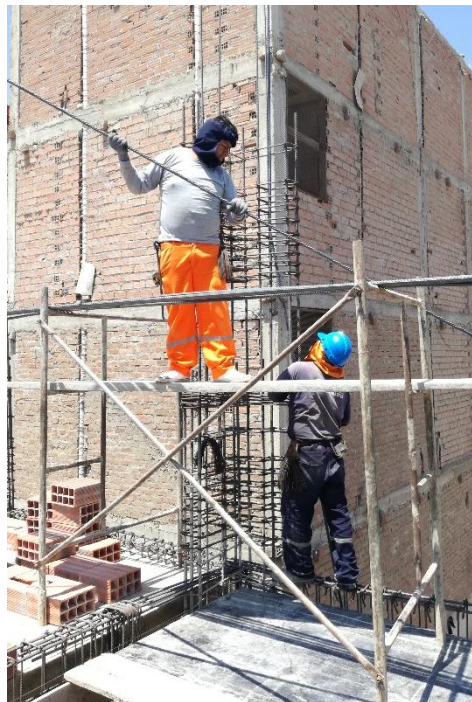
Figura 53 Trabajo Contributorio en la partida de Acero Columnas
