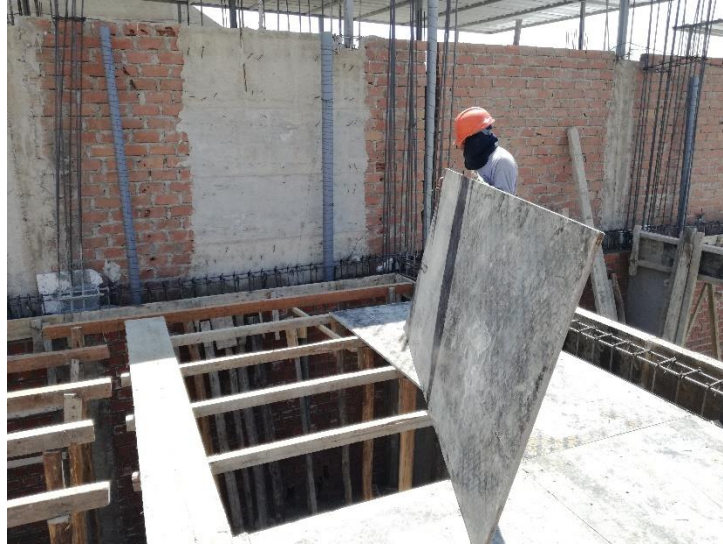
Figura 45 Trabajo Contributorio en la partida de Encofrado de Losa Fuente: Elaboración propia
