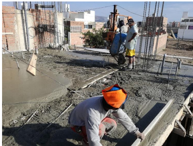
Figura 86 Trabajo Productivo en la partida de Concreto Losa
