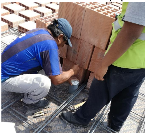
Figura 130 Trabajo Productivo en la Partida de Instalaciones Eléctricas
