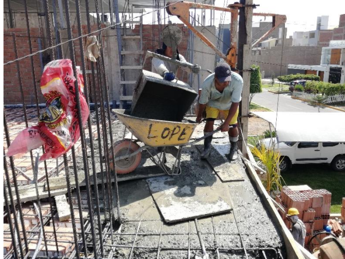
Figura 77 Trabajo Contributorio en la partida de Concreto Columnas
