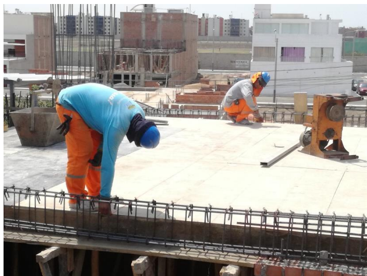
Figura 69 Trabajo Contributorio en la Partida Acero Losa Fuente: Elaboración propia
