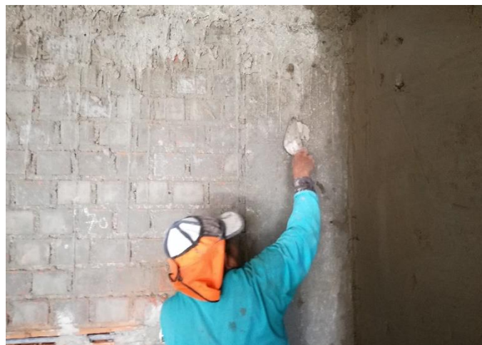
Figura 108 Trabajo Contributorio en la partida Tarrajeo de Muros
