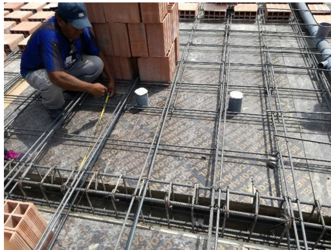
Figura 132 Trabajo Contributorio en la partida de Instalaciones Eléctricas
