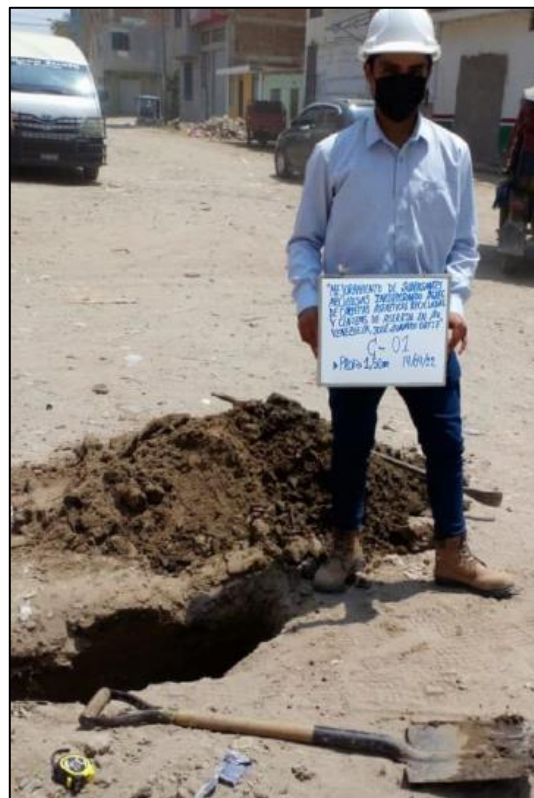
Ilustración N°4.5: Ejecución de Calicata 01. Fuente: Propia
