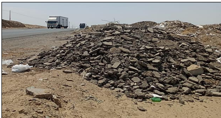
Figura 5: Depósito de carpeta asfáltica en carretera Panamericana Norte (Salida Reque). Fuente: Propia
