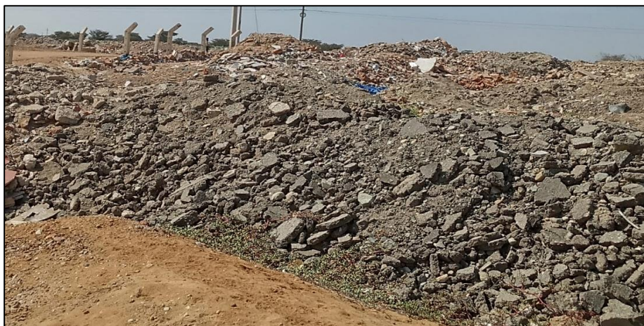
Figura 6: Depósito de carpeta asfáltica en carretera San José (Salida Ciudad de Dios). Fuente: Propia
