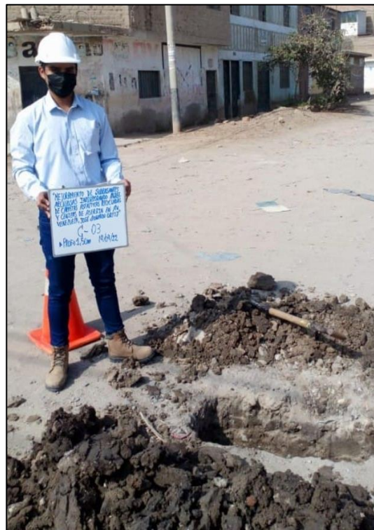
Ilustración N°4.7: Ejecución de Calicata 03. Fuente: Propia
