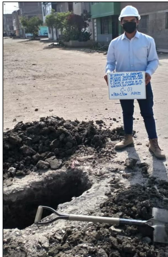
Ilustración N°4.6: Ejecución de Calicata 02. Fuente: Propia
