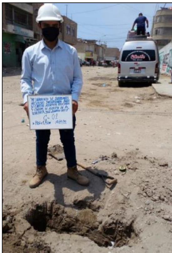
Ilustración N°4.5: Ejecución de Calicata 01. Fuente: Propia
