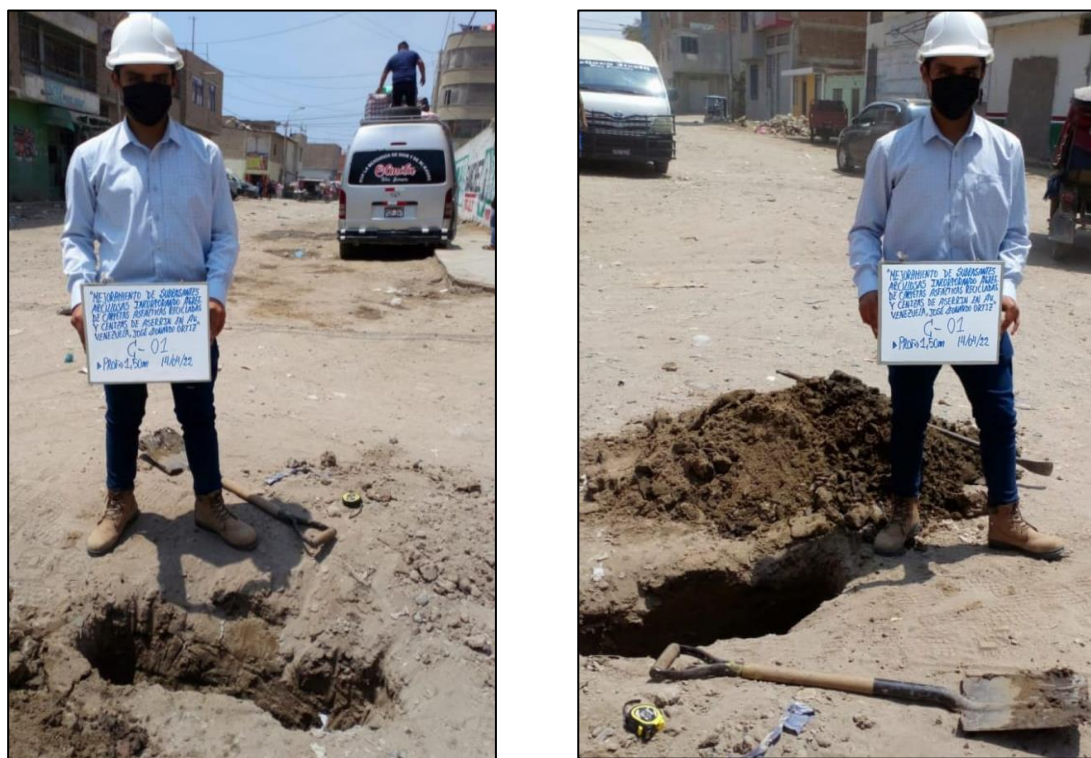
Figura 13: Calicata-01: Intersección Av. Venezuela y España. Fuente: Propia
