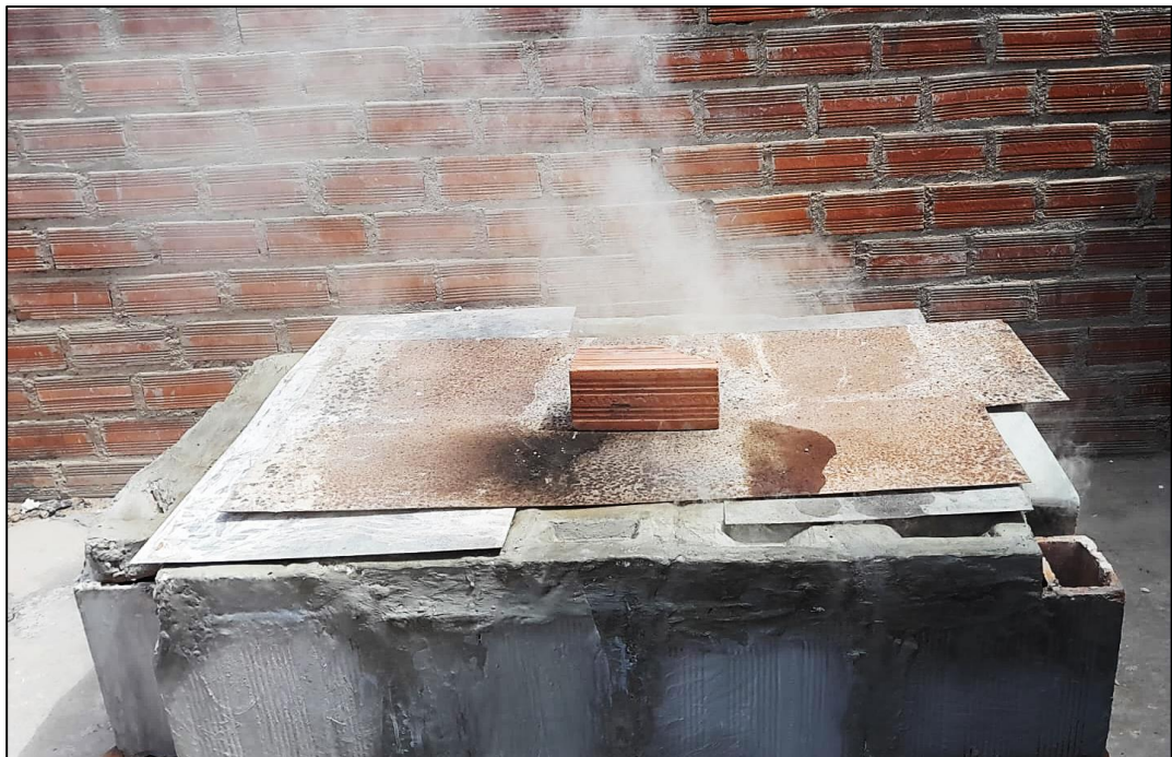
Figura 43: Protección del horno con láminas metálicas. Fuente: Propia
