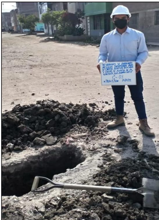
Ilustración N°4.7: Ejecución de Calicata 03. Fuente: Propia
