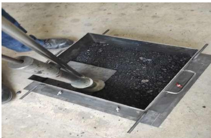
Figura 103: Compactando el asfalto con adición de fibra
