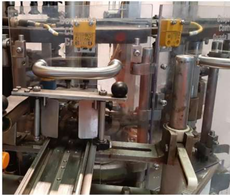
Ubicación del sensor de seguridad, de color amarillo, en una de las puertas
