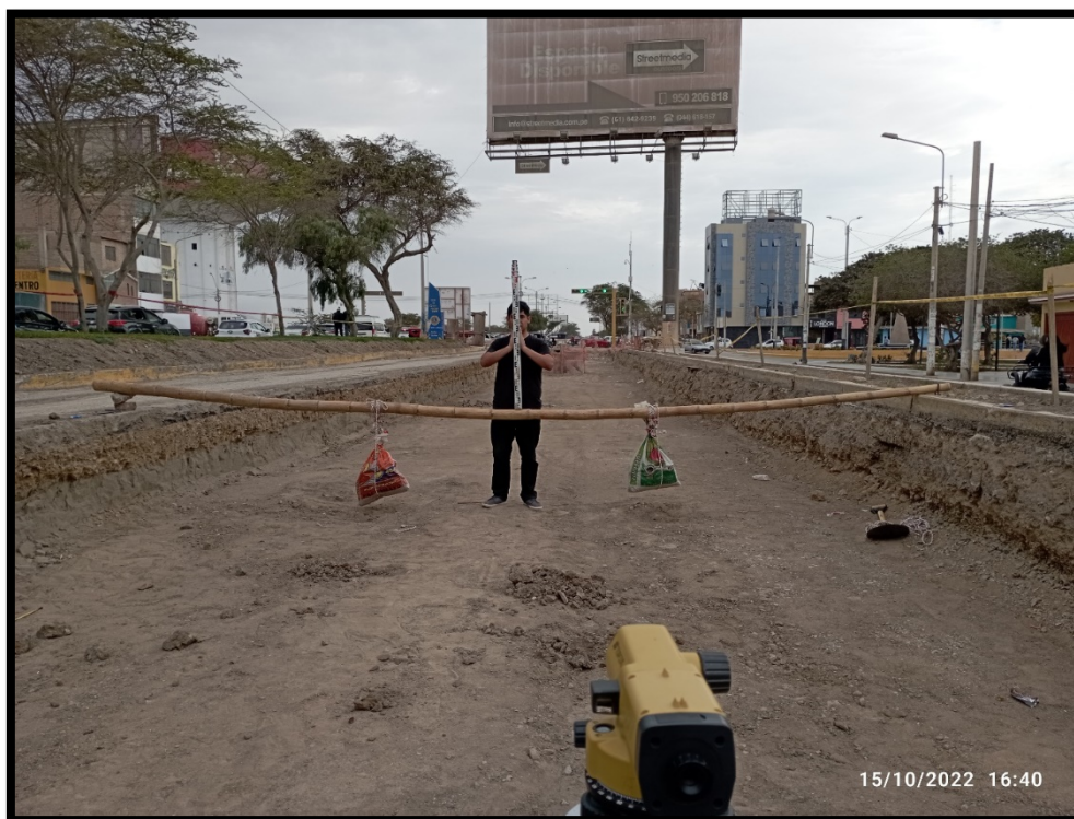
Ilustración 122.- Ensayo empirico a deflexión con Nivel Topográfico
