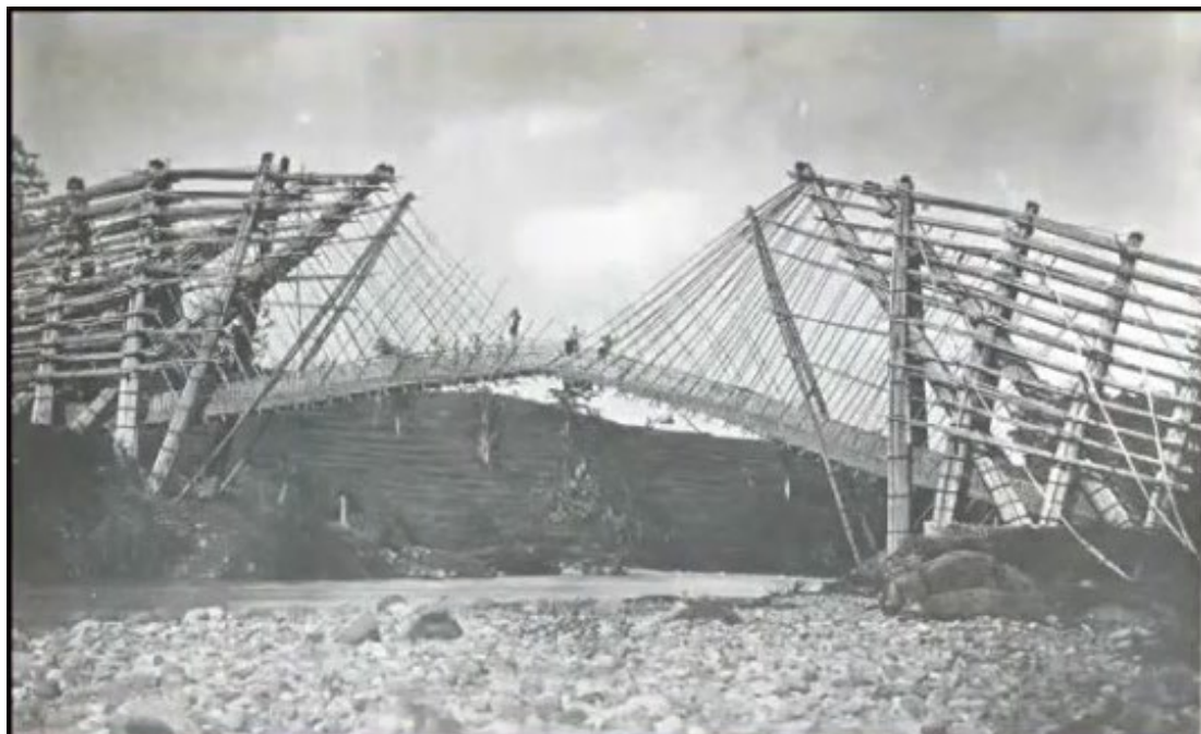
Ilustración 41.- Puente peatonal tipo atirantado realizado en la Isla de Java - Indonesia (1890)
