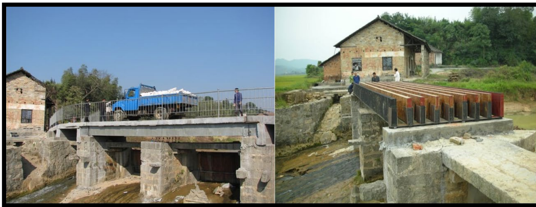
Ilustración 44.- Puente de Bambú y Fibra de Vidrio - Hunan - Daozi (2007)
