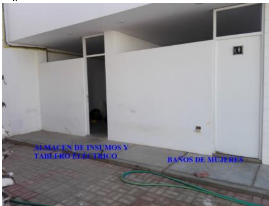
Figura N° 26. Almacén de insumos y baños de mujeres Fuente: DAIRA S.A.C. 2016
