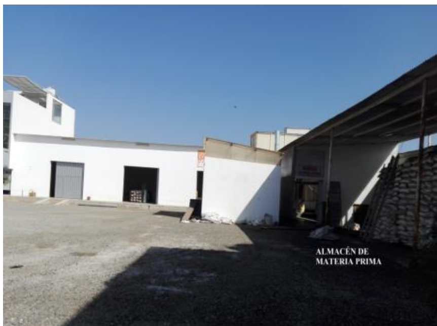
Figura N° 29. Almacenes y área de proceso Fuente: DAIRA S.A.C. 2016
