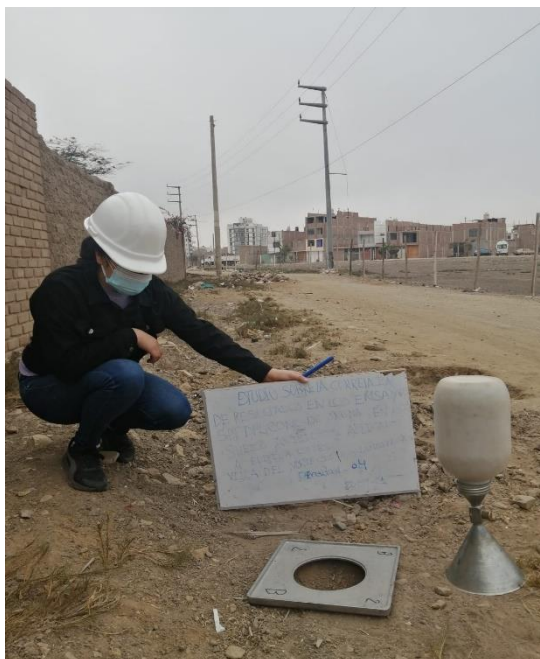
Figura 5. Ensayo de Cono de Arena
