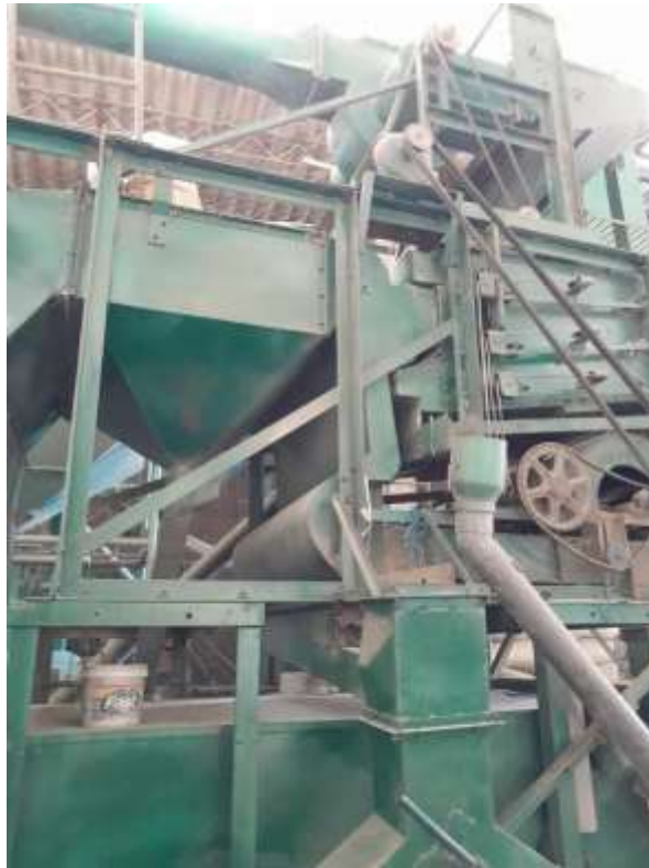
Figura 31. Máquina en mal estado
