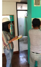
FOTOGRAFÍA 3: Toma de datos columna eje B-2 a una distancia 1.40 m del N.P.T cara interna block B 2do piso
