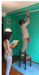
FOTOGRAFÍA 8: Toma de datos viga 2V-2 a una distancia 2.00 m del eje 1 cara interna block B 2do piso
