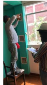
FOTOGRAFÍA 5: Toma de datos columna eje B-3 a una distancia 0.58m, 1.33m y 2.02m del N.P.T cara interna block B 2do piso
