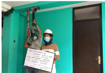
FOTOGRAFÍA 3: Extracción de núcleo diamantino en la VIGA 2V-2 (0,25x0,25m) del departamento 201 block B, propietaria Krissy Alarcón Montero.
