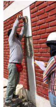
FOTOGRAFÍA 13: Toma de datos columna eje B-3 a una distancia 2.10m del N.P.T cara interna block B 1er piso
