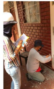
FOTOGRAFÍA 9: Toma de datos columna eje C-3 a una distancia 0.45m del N.P.T cara interna block C 1er piso
