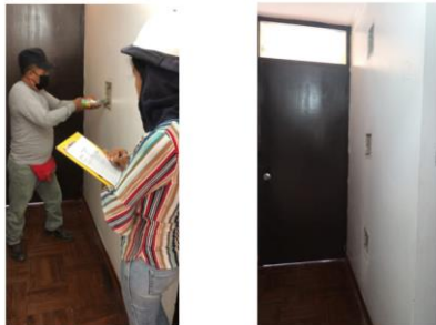
FOTOGRAFÍA 6: Toma de datos columna eje C-2 a una distancia 0.52m, 1.26m y 2.02m del N.P.T cara interna block A 1er piso
