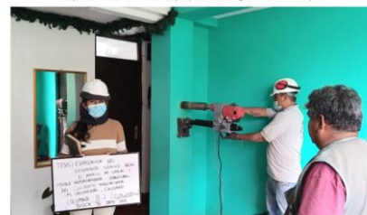
FOTOGRAFÍA 6: Extracción de núcleo diamantino en la COLUMNA B-2 (0,30x0,30m) del departamento 201 block B, propietaria Krissy Alarcón Montero.
