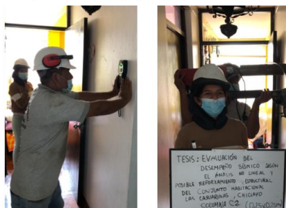
FOTOGRAFÍA 8: Extracción de núcleo diamantino en la COLUMNA C-2 (0,25x0,30m) del departamento 103 block A, propietaria Rosario Lezama Pajares.
