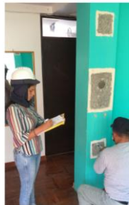
FOTOGRAFÍA 4: Toma de datos columna eje B-2 a una distancia 0.70 m del N.P.T cara interna block B 2do piso
