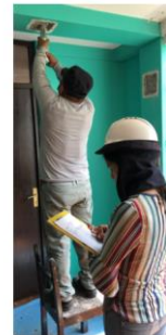
FOTOGRAFÍA 7: Toma de datos viga 2V-2 a una distancia 1.05 m del eje 1 cara interna block B 2do piso
