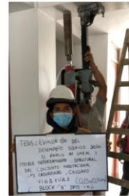
FOTOGRAFÍA 4: Extracción de núcleo diamantino en la VIGA 1VA-2 (0,25x0,30m) del departamento 102 block B, propietaria Margarita Ventura Zapata.
