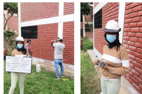
FOTOGRAFÍA 9: Extracción de núcleo diamantino en la COLUMNA B-3 (0,25x0,25m) del departamento 103 block B, propietaria Blanca Vásquez.
