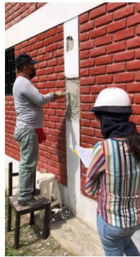
FOTOGRAFÍA 12: Toma de datos columna eje B-3 a una distancia 1.21m del N.P.T cara interna block B 1er piso
