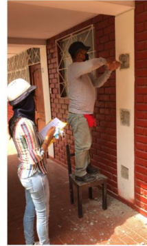
FOTOGRAFÍA 11: Toma de datos columna eje C-3 a una distancia 1.82m del N.P.T cara interna block C 1er piso
