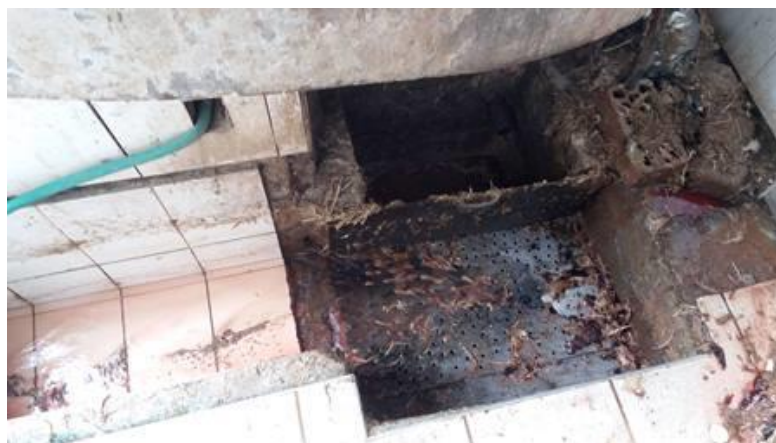
1- Punto de salida hacia desagüe urbano
