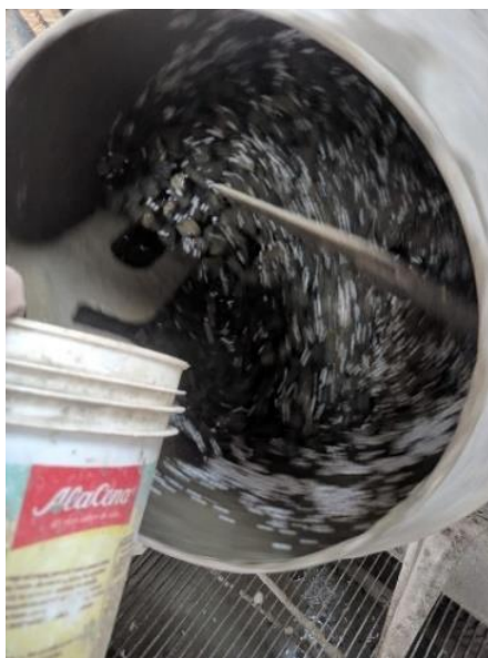
Imagen 11. Mezclado de concreto liviano
