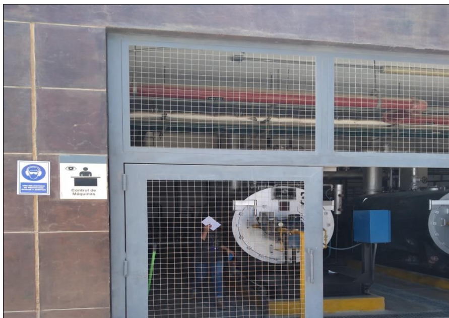
Figura 31. Señalización exterior preventiva colocada en servicio de calderos de empresa de estudio
