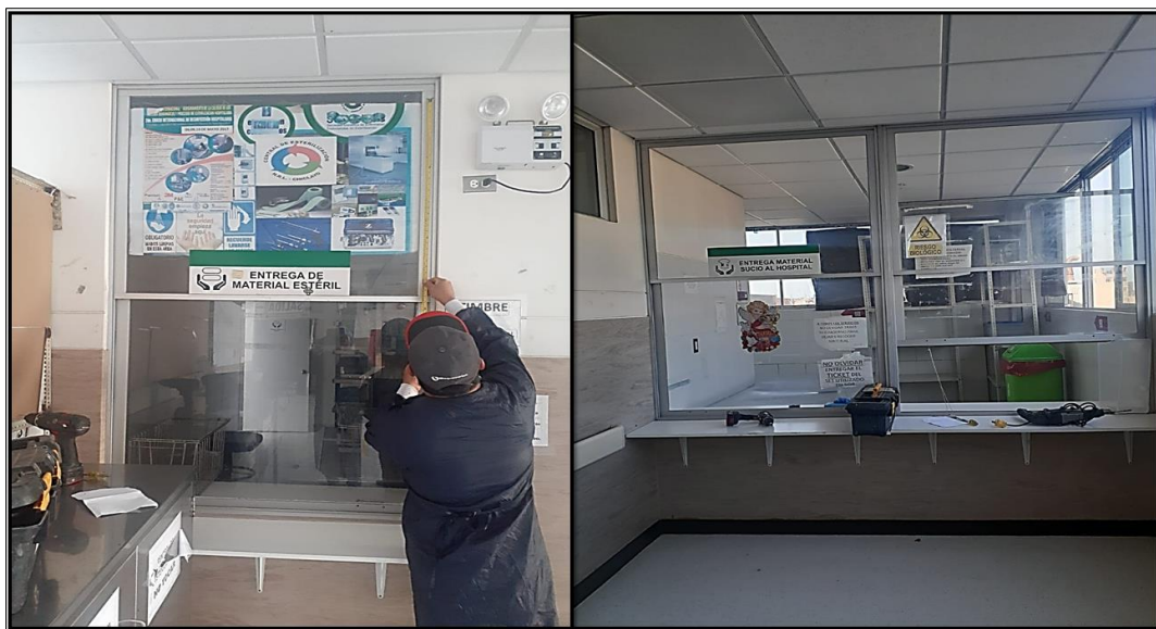
Figura 28. Detalle de trabajos instalación de ventanas tipo guillotina en servicio de central de esterilización de empresa de estudio
