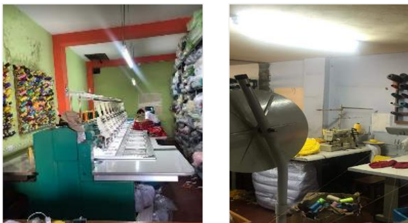
Figura 29. Techo, paredes y suelo de primera y segunda planta
