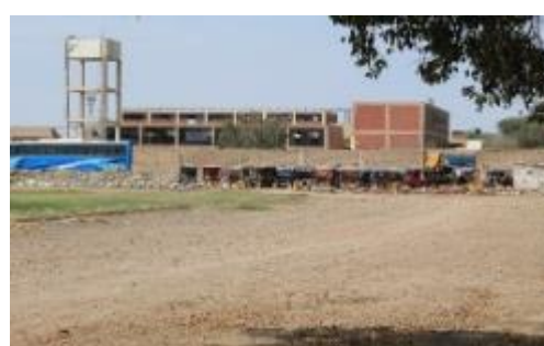
Imagen n°87 Interior del estadio – depósito de mototaxis/ Fuente: Elaboración Propia
