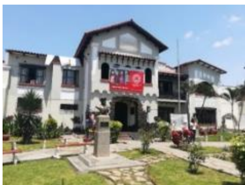
Imagen n°99 Acceso principal al Ministerio de Cultura/ Fuente: Elaboración Propia
