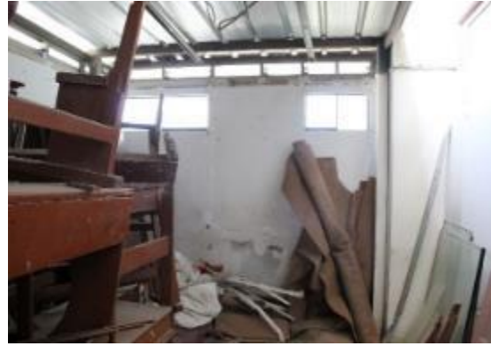
Imagen n°34 Ambiente convertido en depósito / Fuente: Elaboración Propia
