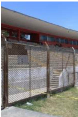
Imagen n°113 Infraestructura sin mantenimiento/ Fuente: Elaboración Propia
