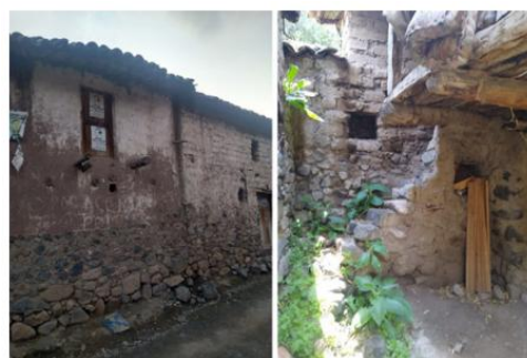
Figura 3. Muros de mampostería de piedra y barro. A la izquierda, fachada frontal donde se aprecia dichos elementos; a la izquierda, integración de muro y escaleras de acceso vertical. Fuente: Autor.
