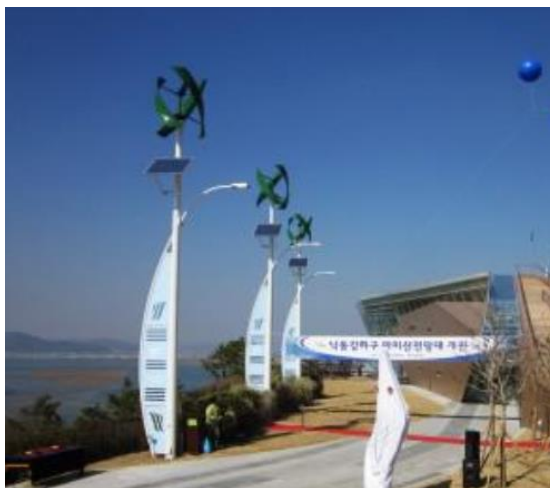
Figura 2. Farola con aerogenerador híbrido de UGE en Busan, Corea.
