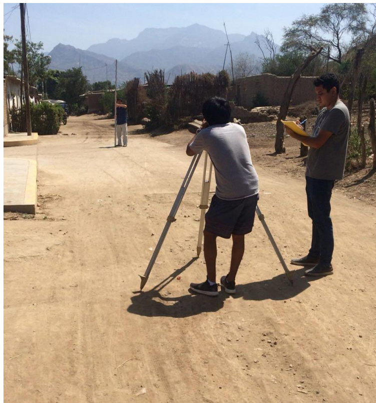
Fotografía 2.22. Levantamiento con nivel
