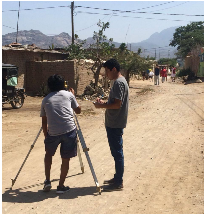
Fotografía 2.21. Levantamiento con nivel
