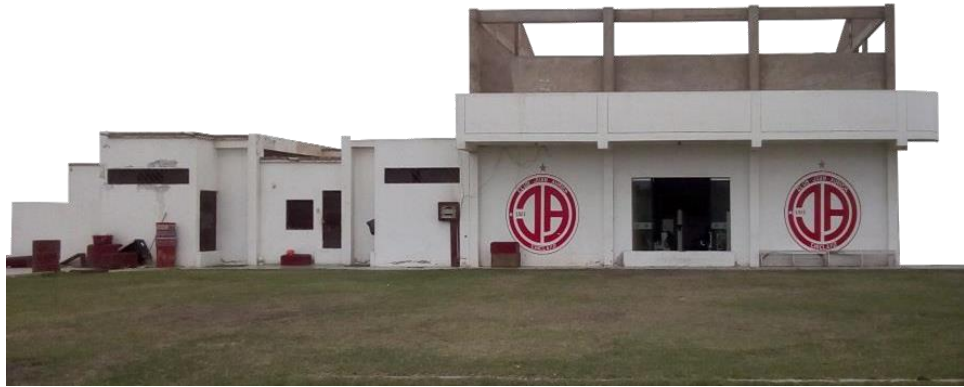
Imagen 45. Materialidad de los cerramientos exteriores del volumen A del proyecto. Fuente: Fotografía Propia.
