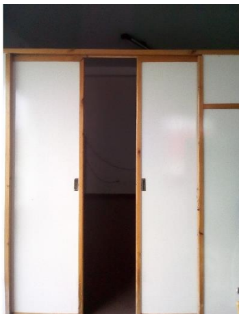
Imagen 47. Tabiquería, planchas de madera.
