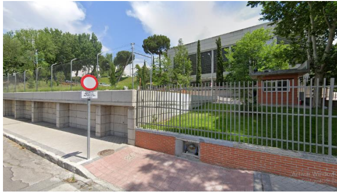
Imagen 100. Materialidad del cerco perimétrico del C.A.R. de Madrid: Google Maps.
