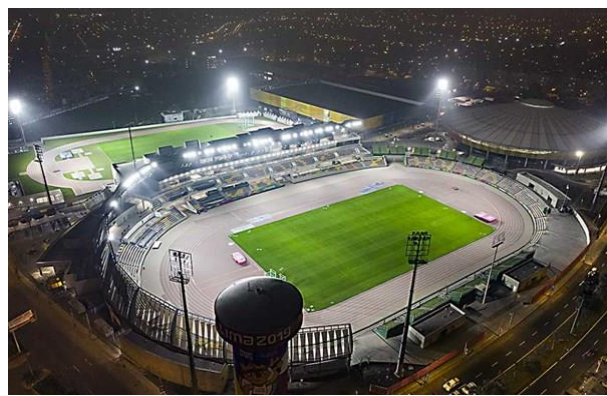
Imagen 73. Espacios deportivos de gran envergadura. Fuente: El Peruano.
