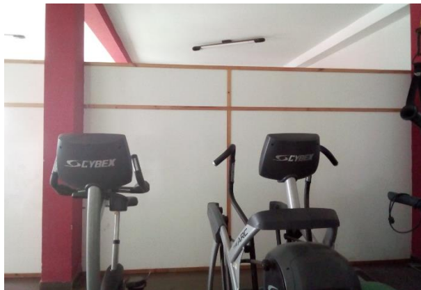
Imagen 49. Gimnasio con muros de tabiquería de planchas de madera. Fuente: Fotografía Propia.
