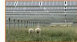
Granja solar de generación
