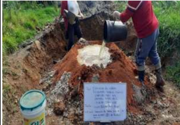
Figura 103: Mezcla de materiales para adobes de 10% -15%
