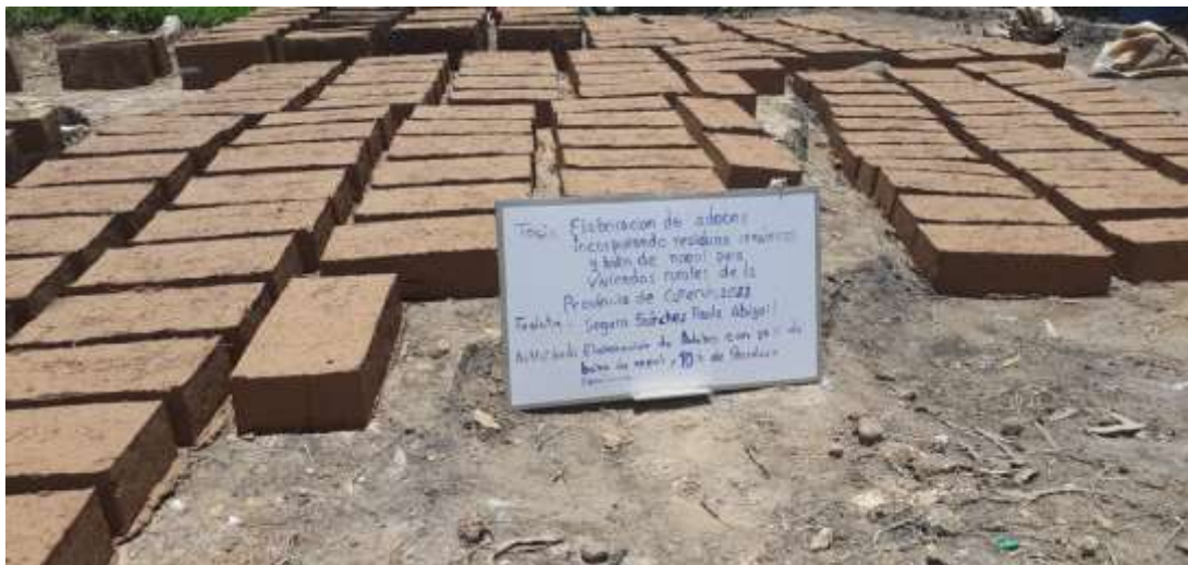
Figura 104: Secado de adobes con 10% de RC y 15 de baba de nopal
