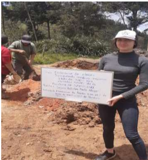
Figura 105: Mezcla de adobes con 20% de RC y 15% de baba de nopal
