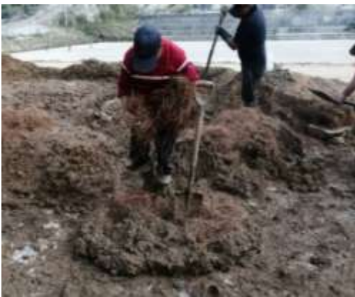
Figura 78: Mezcla de adobes patrones
