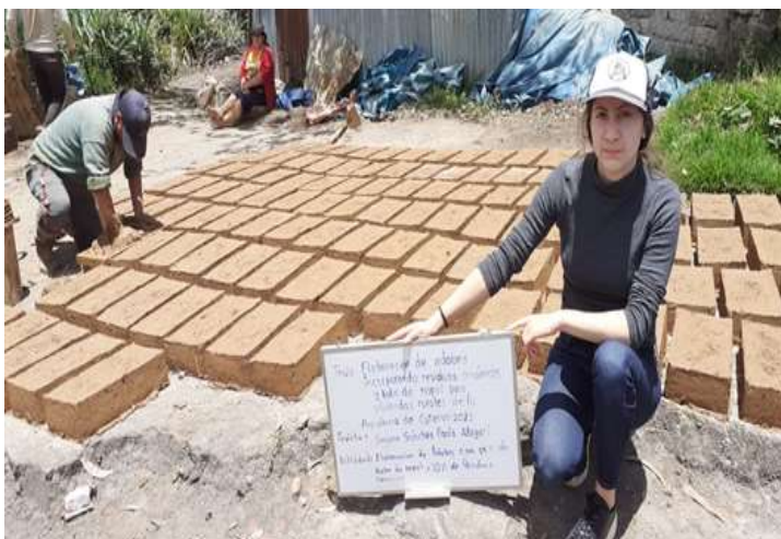
Figura 109: Amoldamiento de adobes con 30% de RC y 15% de baba de nopal
