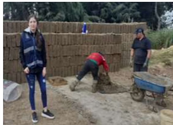
Figura 79: Amoldamiento de adobes patrones
