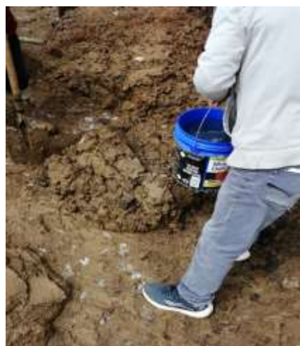
Figura 115: Incorporación de baba de nopal a la mezcla
