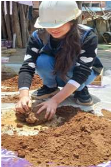
Figura 17: Preparación de la mezcla M-2
