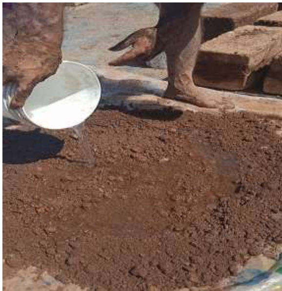
Figura 128: Preparación del mortero con baba de nopal
