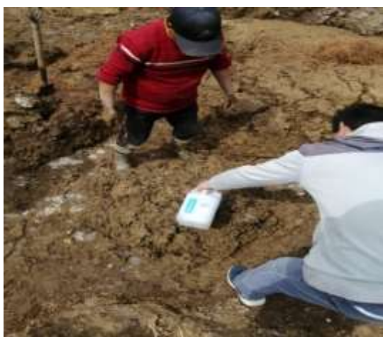
Figura 80: Mezclado con baba de nopal
