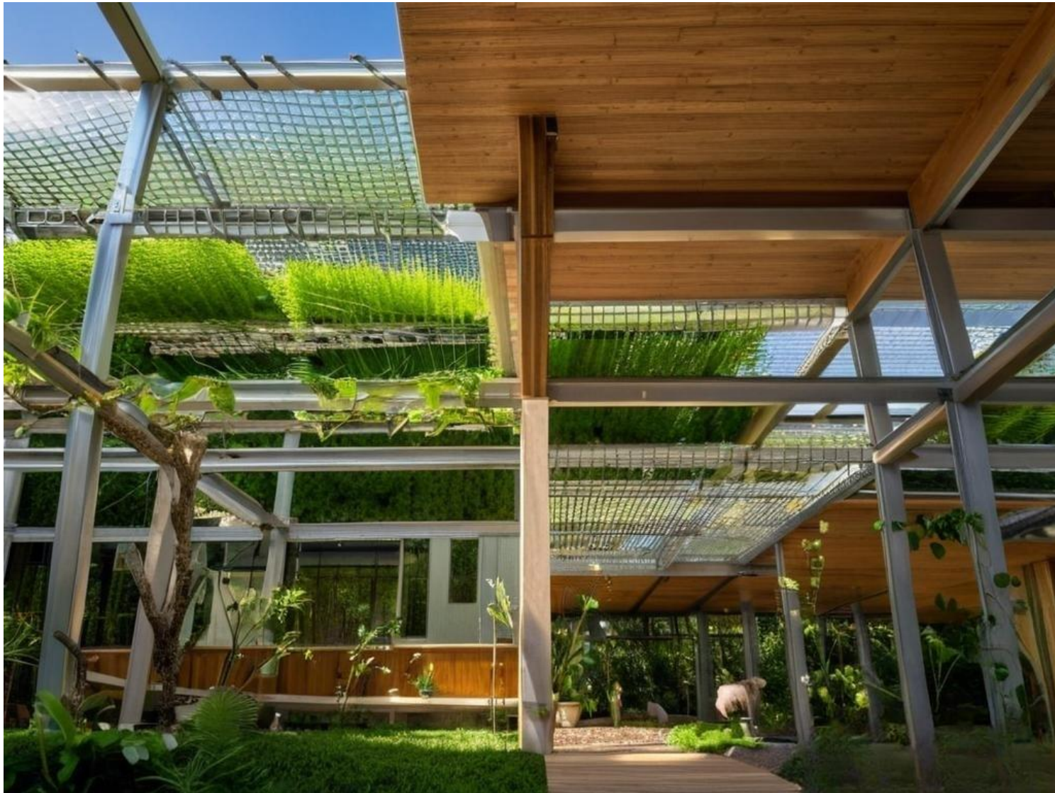
Anexo 36. Vista exterior del Centro, relación paisaje- arquitectura, senderos dentro del centro de investigación.
