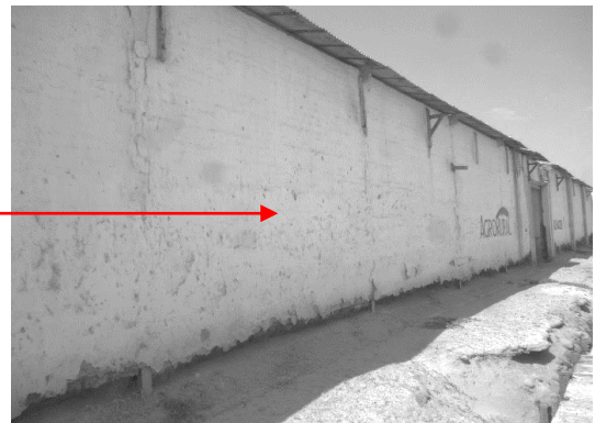
Imagen N° 61. Muro de adobe.
