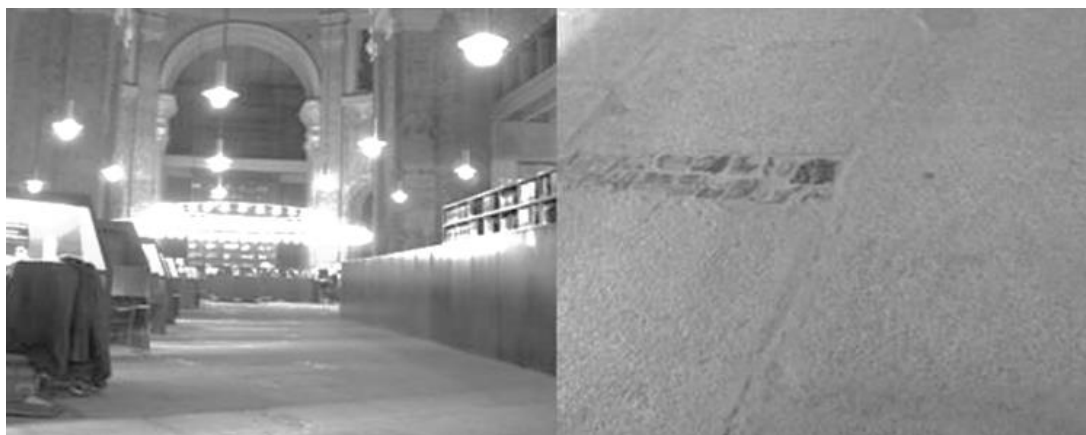
Imagen N° 115. Rehabilitación de la biblioteca UNED-Madrid.
