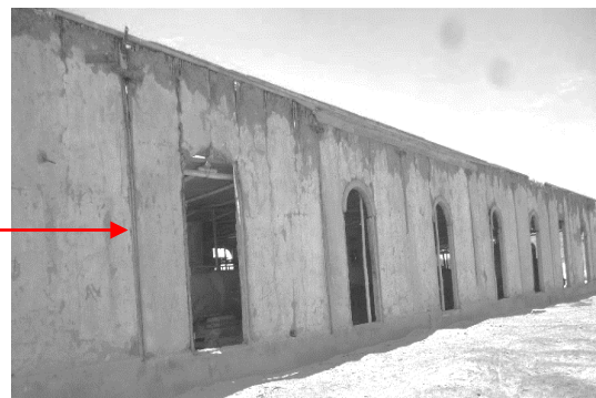
Imagen N° 64. Columnas con rieles metálicos.
