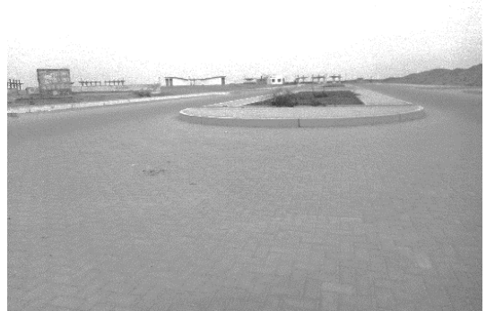
Imagen N° 52. Acceso a Malecón de Puerto Eten.
