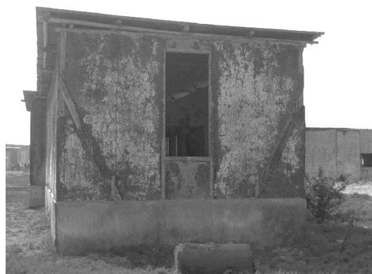
Imagen N° 78. Revestimiento de yeso.
