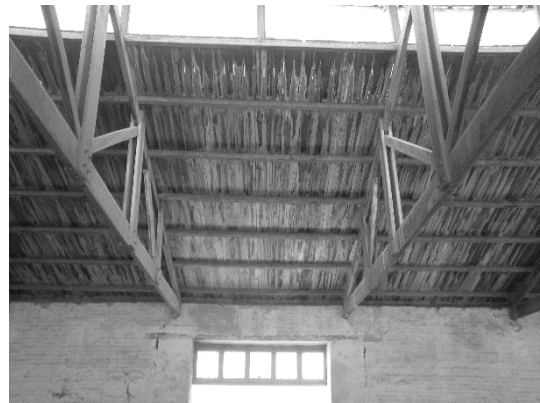
Imagen Nº 66. Cubierta original de tablones de madera.
