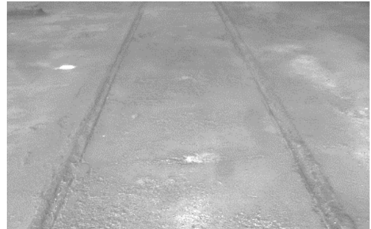
Imagen N° 75: Piso de concreto pulido.
