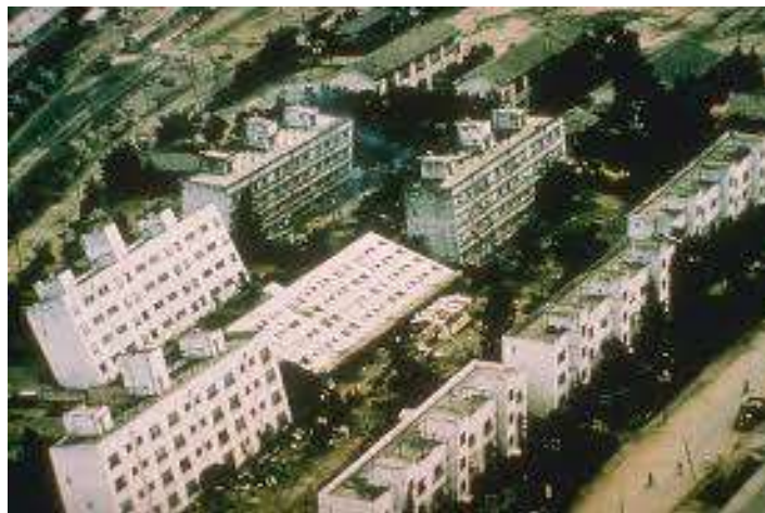
Imagen 6. Asentamientos estructurales causados por la licuefacción de suelos durante el sismo de Niigata, 1964
