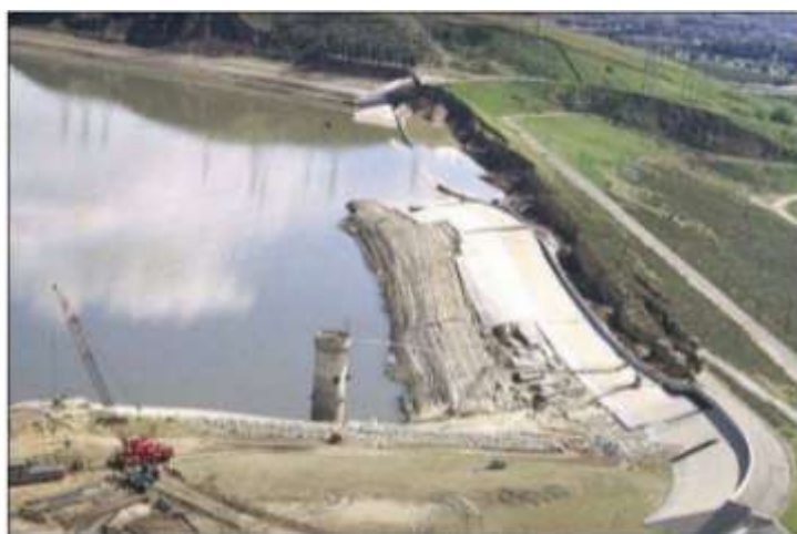
Imagen 2. Falla por flujo presa San Fernando 09/02/1971
