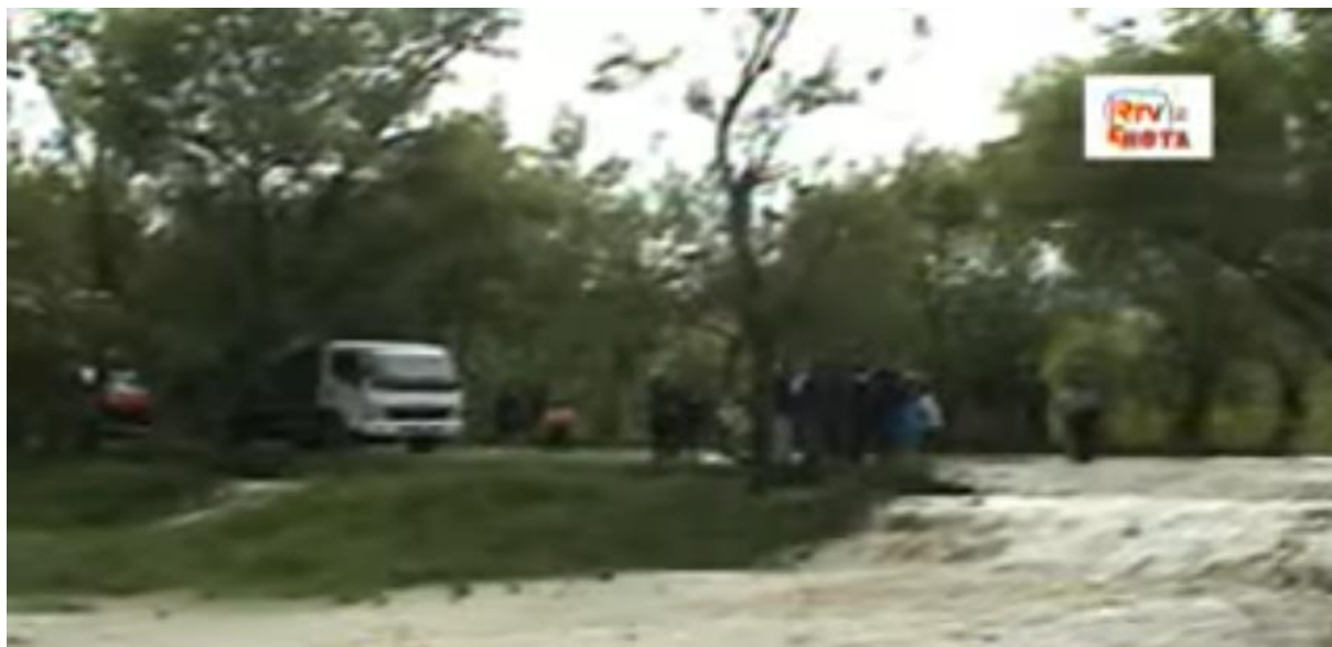
Anexo 01. Desborde del río Chotano provocando daños en la carretera Chota-Túnel Conchano, 2009.
