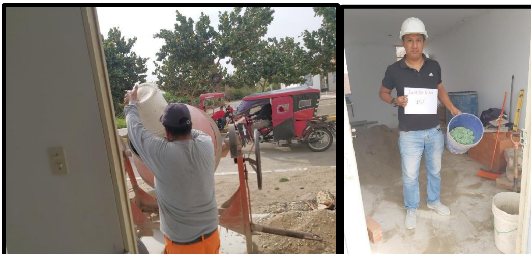
Fig. 28: Se realizo el mezclado de los agregados para mortero junto con la lana de vidrio en un trompo mezclador para que se realice de manera homogénea Fuente: Propia
