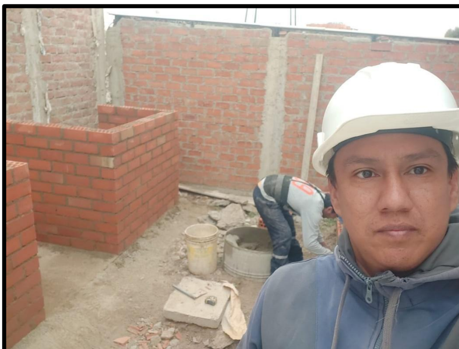
Fig. 26: La junta horizontal fue de 1.5cm y la vertical de 1.5cm y con asentado tipo sogá
