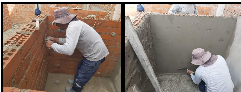
Fig. 29: Se pusieron las cuñas de espesor para controlar un correcto tarrajeo Fuente: Propia
