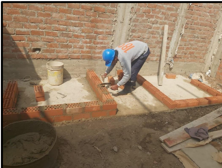
Fig. 25: Asentado de ladrillo. Se usó ladrillo 18H, cemento Fortimax Pacasmayo y arena amarilla
