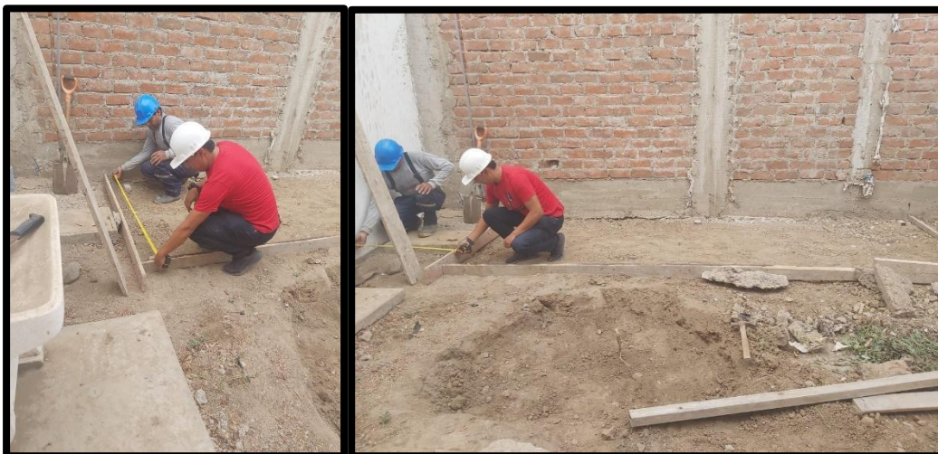
Fig. 23: Nivelación y trazo para la construcción de módulos a escala
