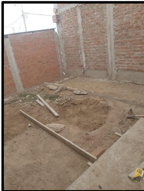
Fig. 22: Limpieza de terreno Fuente: Propia
