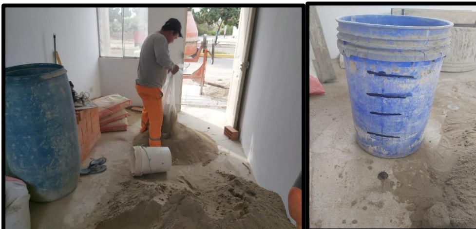
Fig. 27: Preparación de arena fina para tarrajeo y adición de lana de vidrio Fuente: Propia
