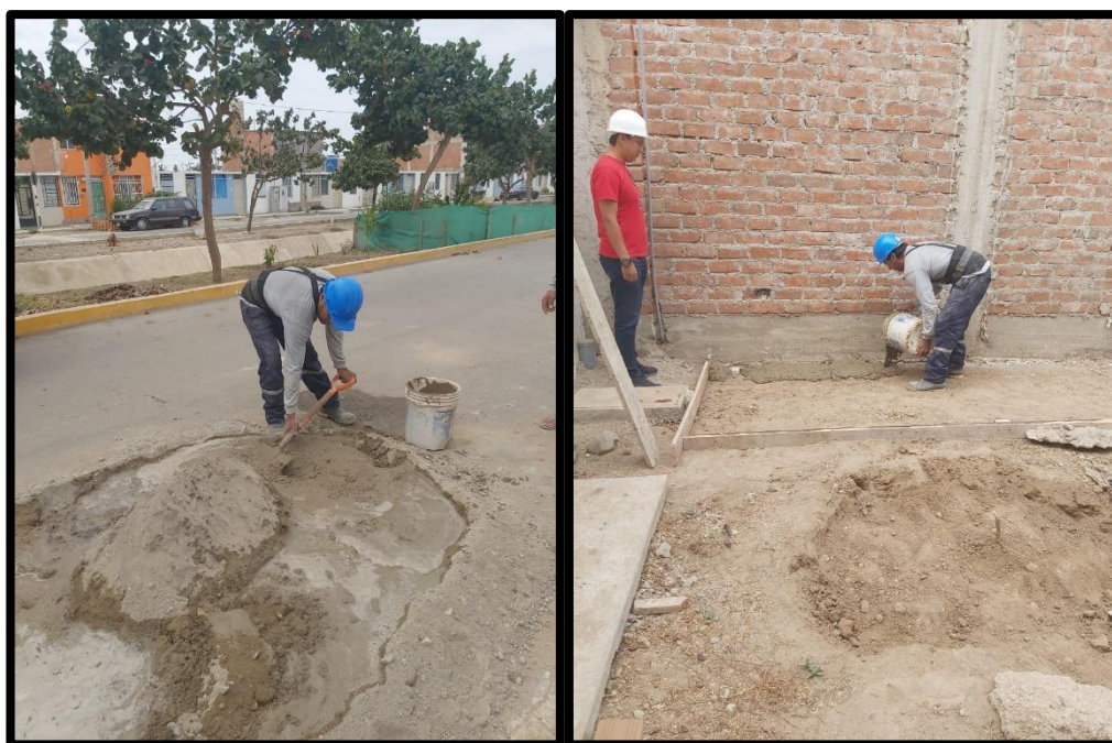
Fig. 24: Preparación del concreto ciclópeo para la losa de piso
